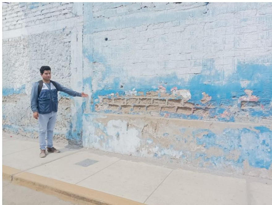
Figura 87. Inspección visual en campo del muro del cerco perimétrico – frente 3
