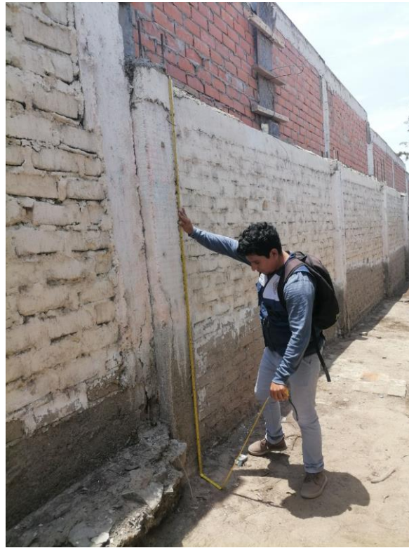
Figura 84. Medición en campo de la columna parte del cerco perimétrico – frente 1.
