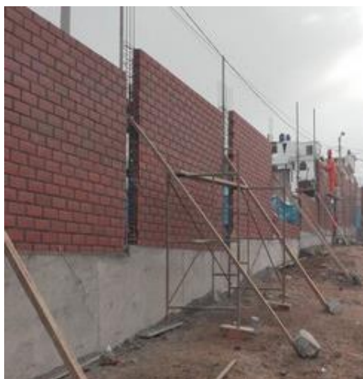
Figura 1. Sobrecimiento de cerco perimétrico
