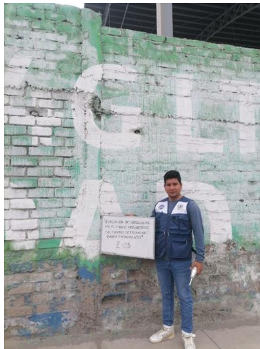
Figura 95. Toma de muestra con el equipo esclerómetro de la columna E-05-frente 3.
