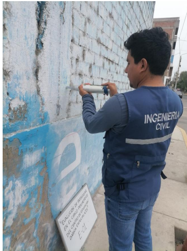
Figura 90. Ensayo de esclerometría columna E-01 – frente 3.
