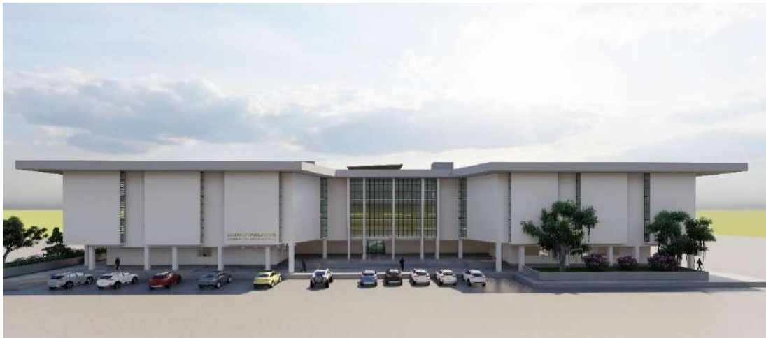
Figura 46. Vista principal de la municipalidad distrital de Independencia
