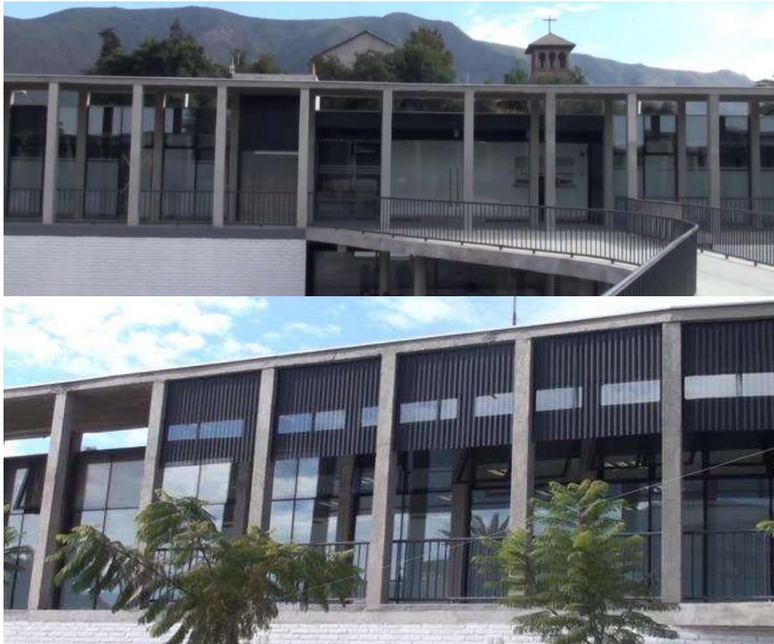
Figura 24. Materiales y acabados constructivos
