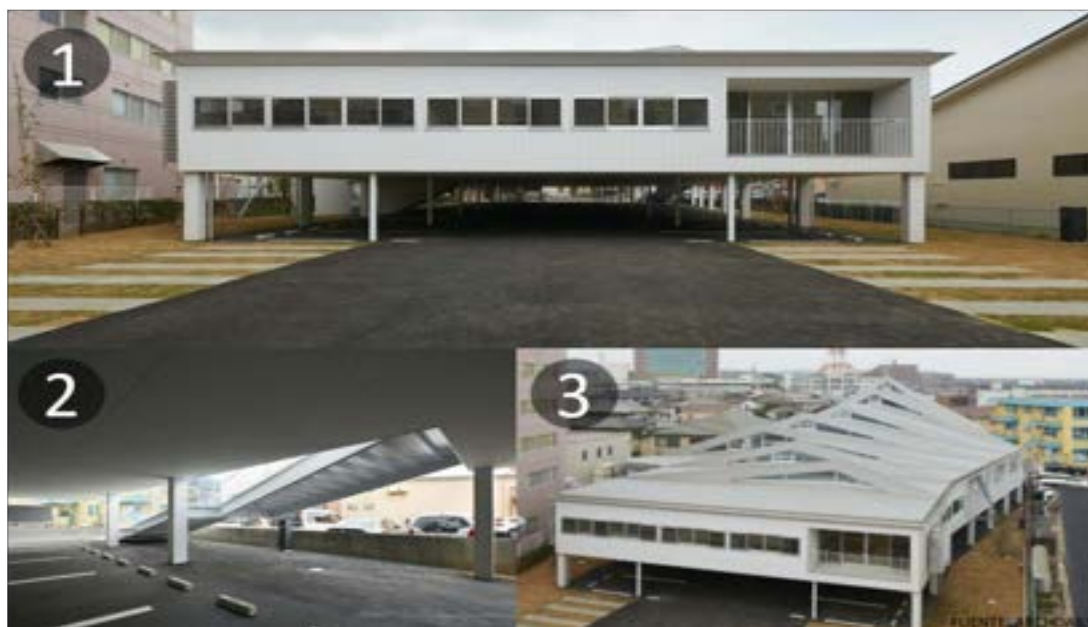
Figura 31. Vistas exteriores, Iglesia católica de Suzuka. Fuente archdaily
