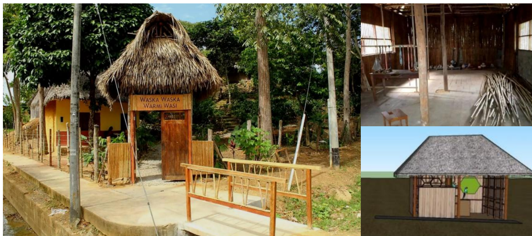
Figura 21. Materialidad y conexión con el entorno mediato del Centro Cultural Waska Waska Warmi Wasi. Fuente: Turse
