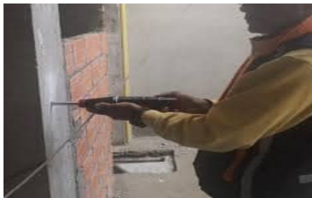
Figura N°7: Ensayo de esclerometría
