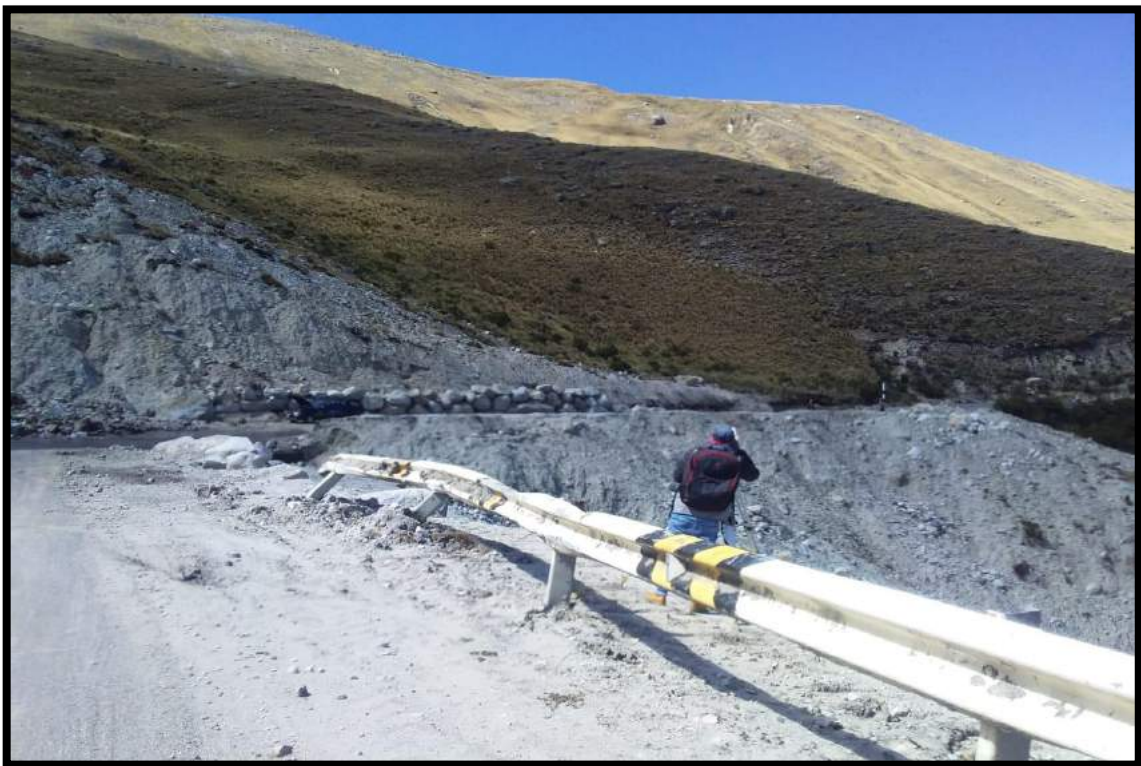
Anexo 03 y 04 Levantamiento topográfico con la estación total.
