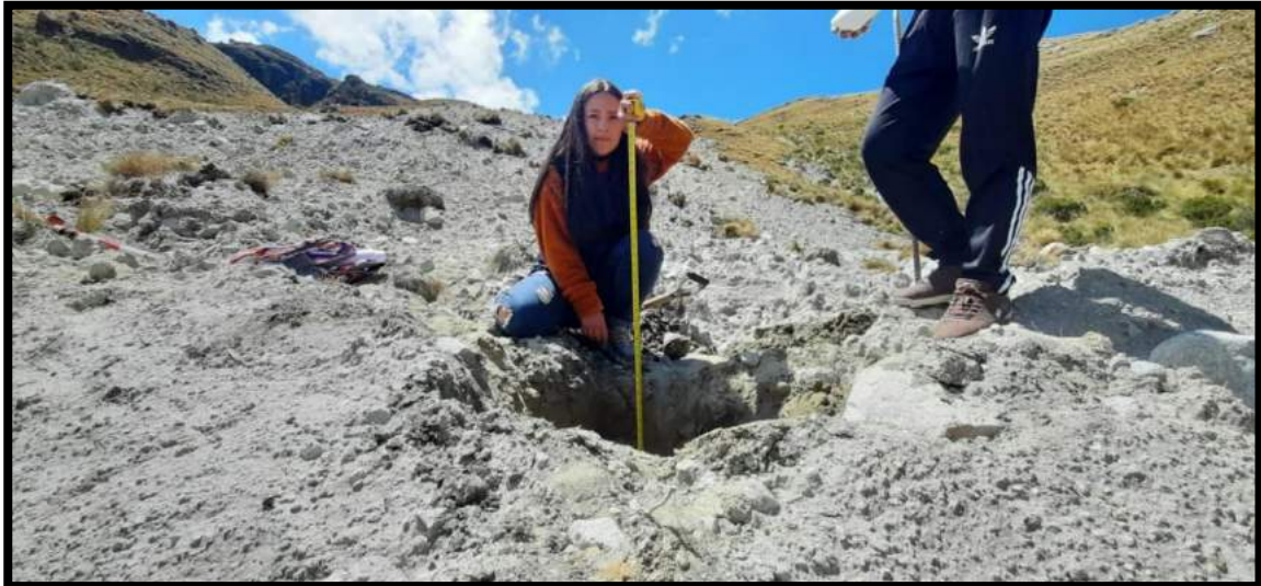
Anexo 09 y 10: Excavación de Calicata N° 02 a una profundidad de 2.00 m
