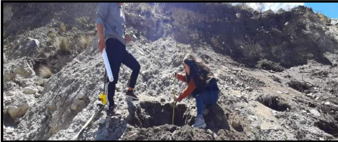
Anexo 08 y 09: Excavación de Calicata N° 01 a una profundidad de 2.00 m
