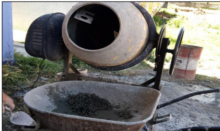
Fotografía 07: Elaboración de mezcla para concreto permeable con gradación de \frac{1}{2} ".
