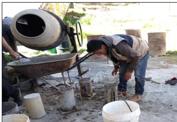
Fotografía 08: Llenado de concreto permeable con gradación de \frac{1}{2} ".
