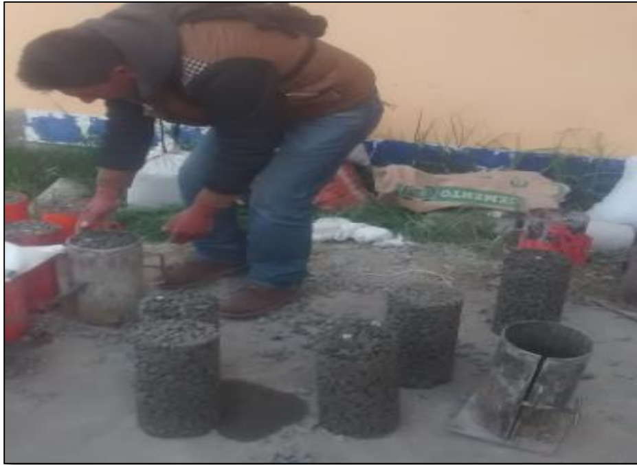
Fotografía 09: Desencofrado de probetas de concreto permeable.
