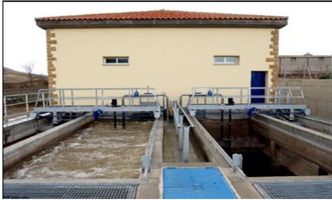
Figura 17 Desarenador Aireado Rectangular
