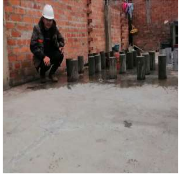
Foto N°26: Desencofrado de moldes de probetas y curado con agua potable por los 28 días.
