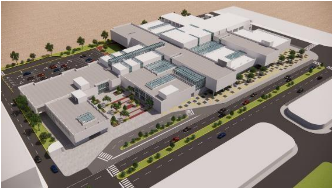
Vista panorámica del proyecto.
