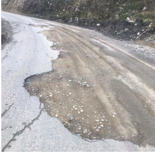
Figura 21. Baches de alta severidad.
