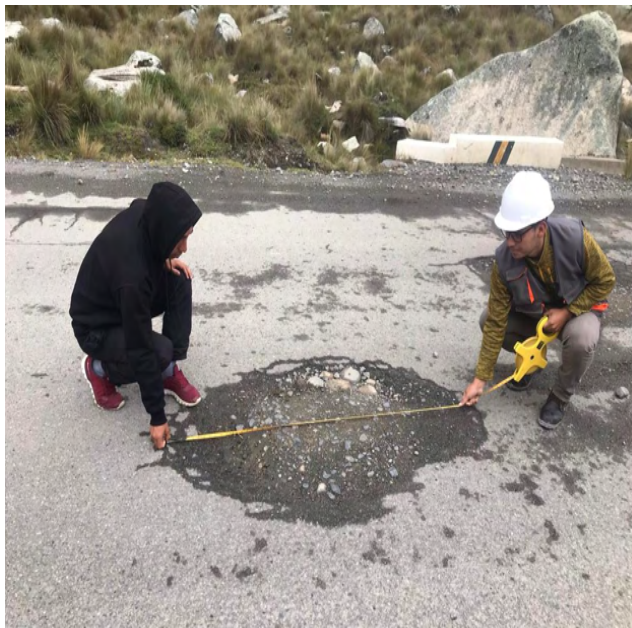
Figura 22. Baches en mayor dimensión en alto nivel de deterioro.
