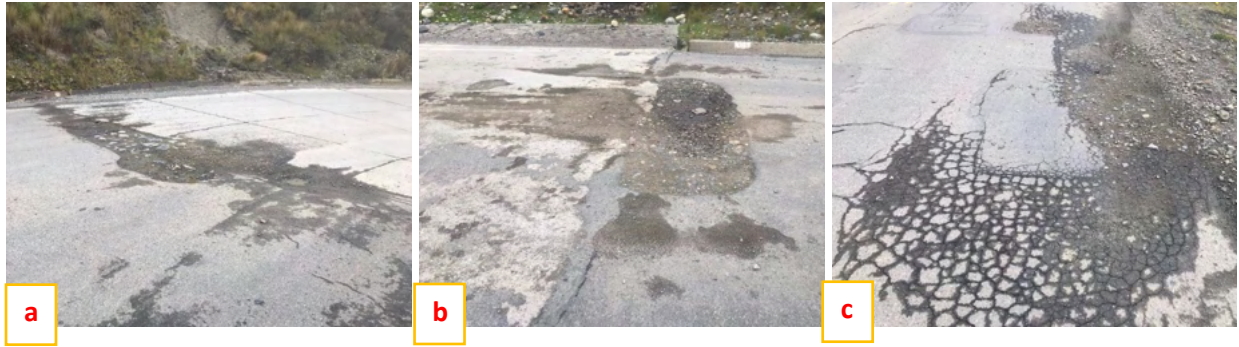
Figura 4. Niveles de gravedad de la piel de cocodrilo: bajo (a), medio (b) y alto (c) (Fuente: Rodríguez, 2009).
