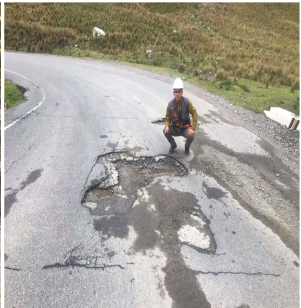
Figura 22. Baches en mayor dimensión en alto nivel de deterioro.
