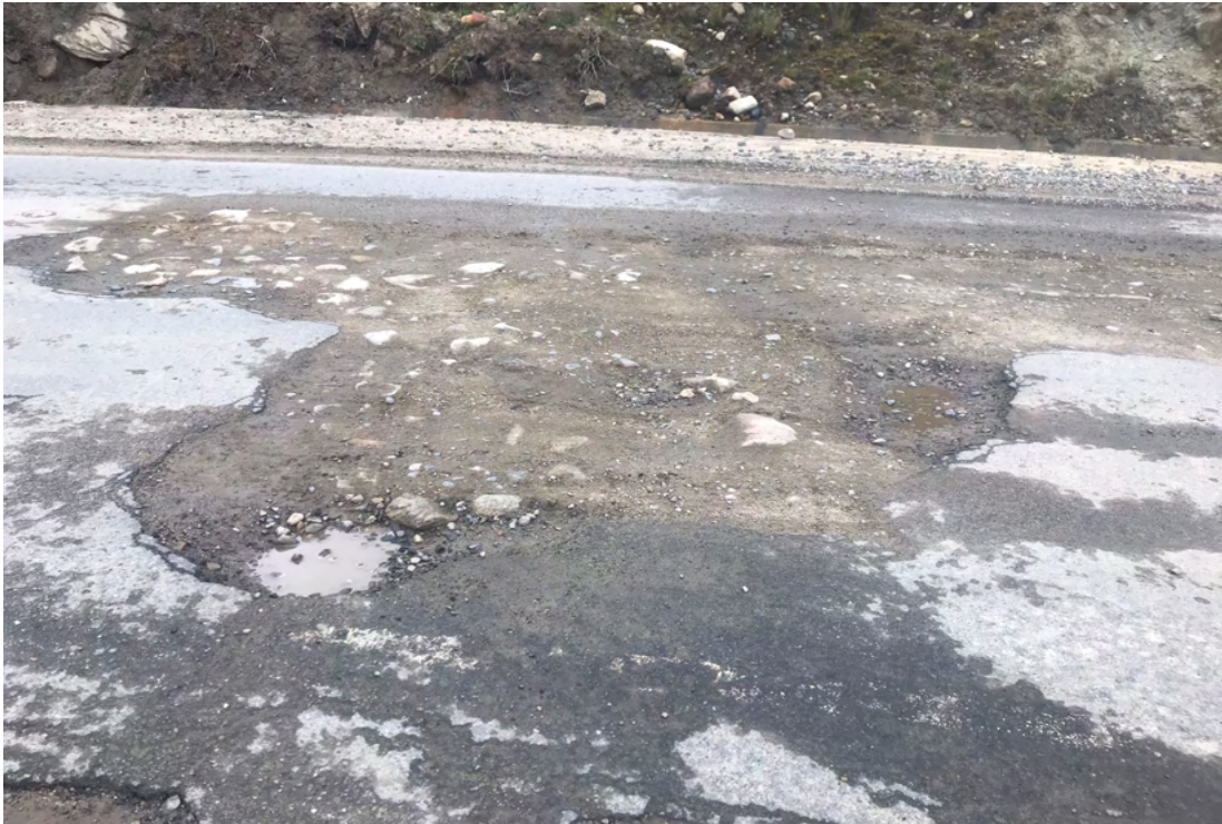
Figura 15. Las celdas de muestra tienen agujeros moderados.
