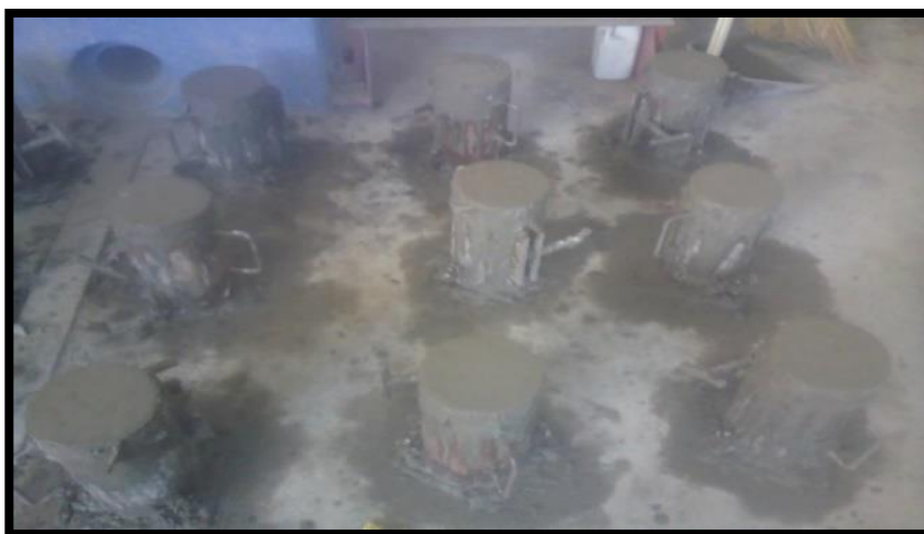
Figura 21: Preparado de concreto
