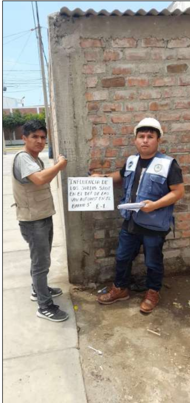
Ensayo de esclerometría en las columnas de las viviendas en la zona evaluada.
