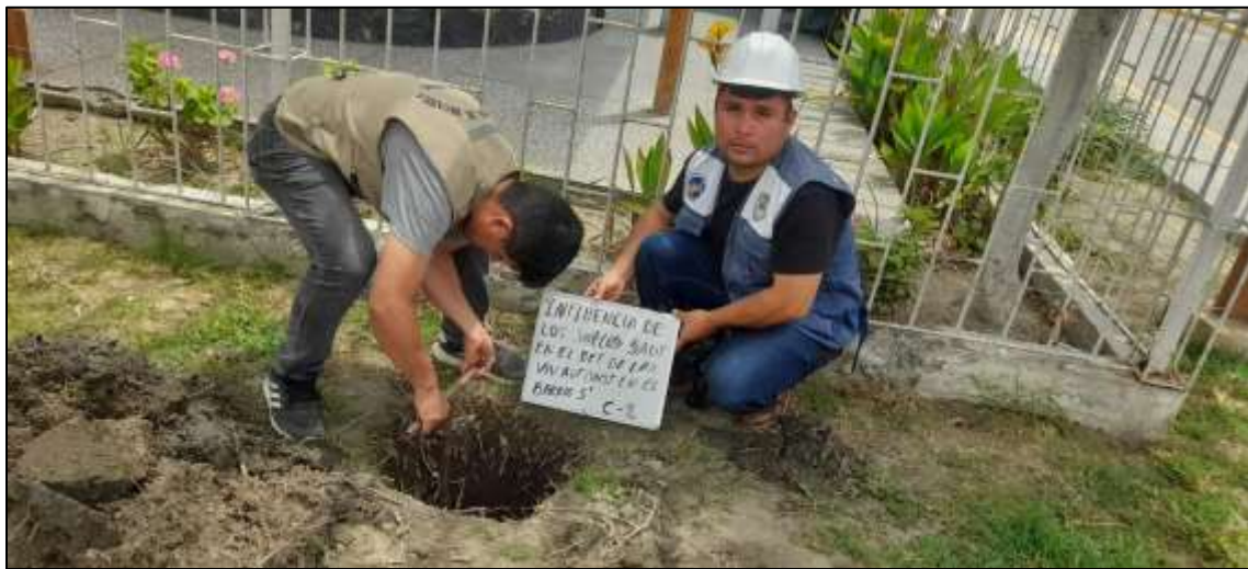
2da calicata realizada en campo (Barrio Fiscal N°5).
