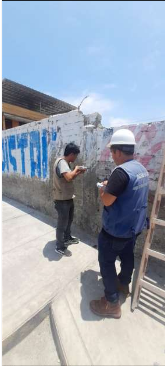
Ensayo de esclerometría para ver la resistencia del concreto.
