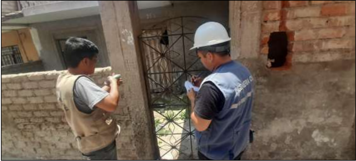
Ensayo de esclerometría.
