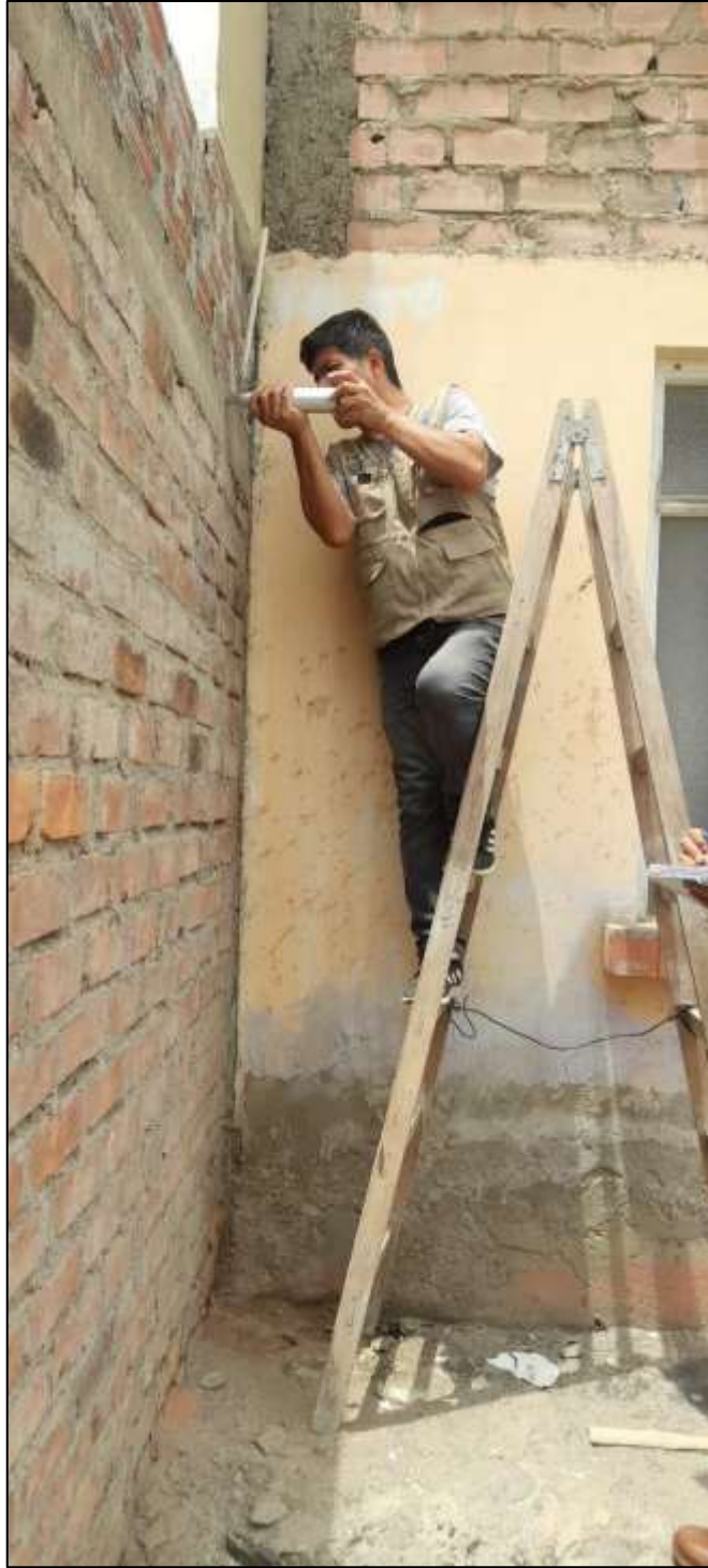
Ensayo de esclerometría en vigas.
