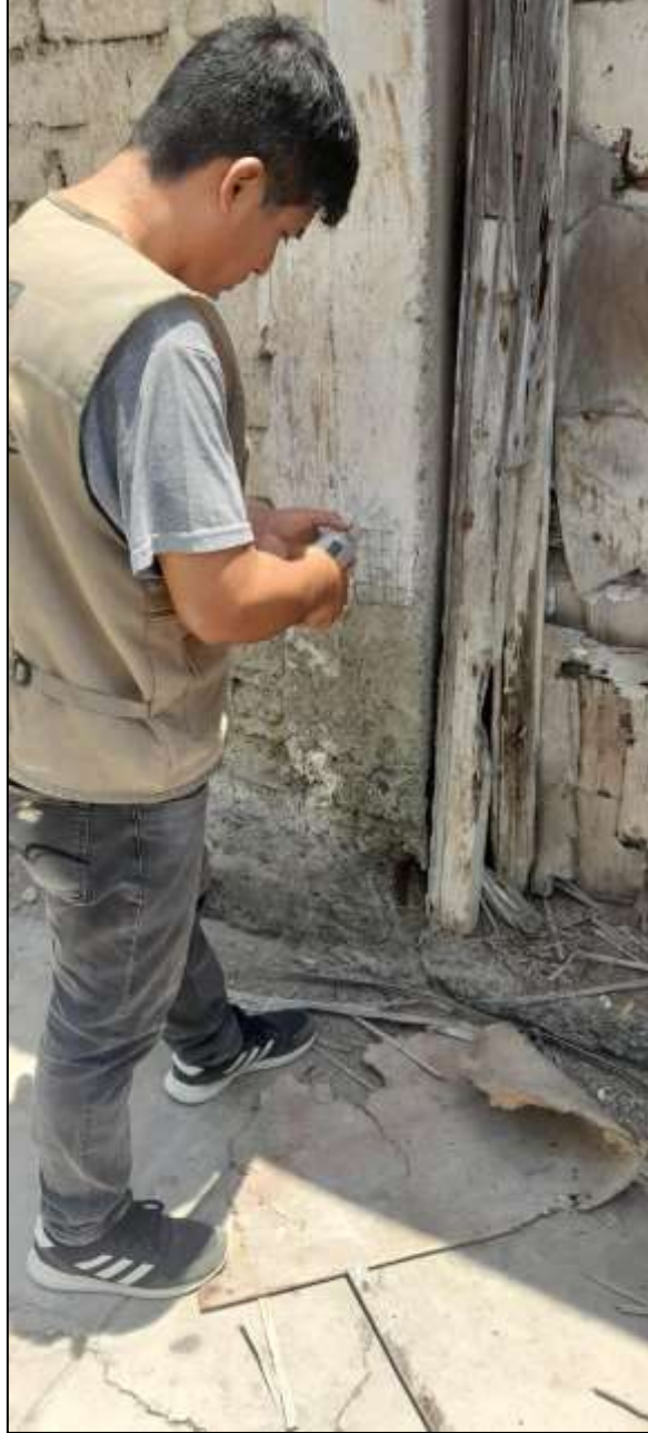
Ensayo de esclerometría.
