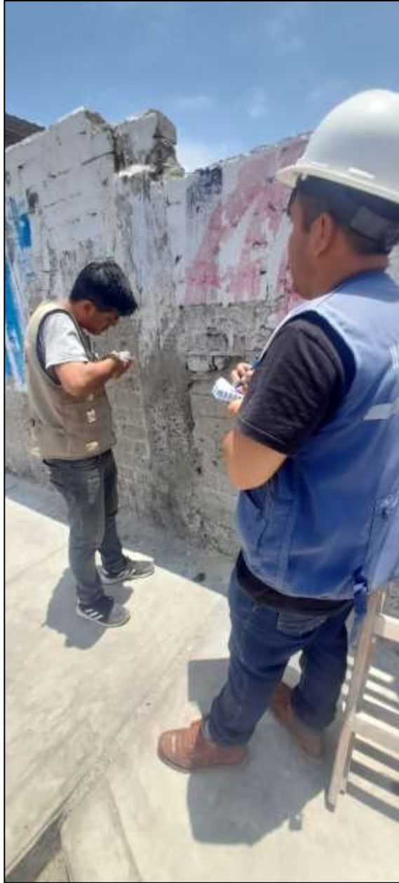
Ensayo de esclerometría.
