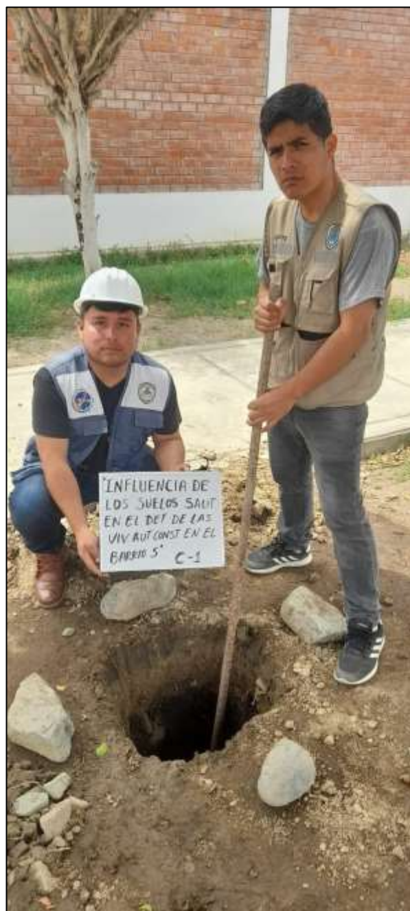
Imagen de la Ira calicata en el Barrio 5.
