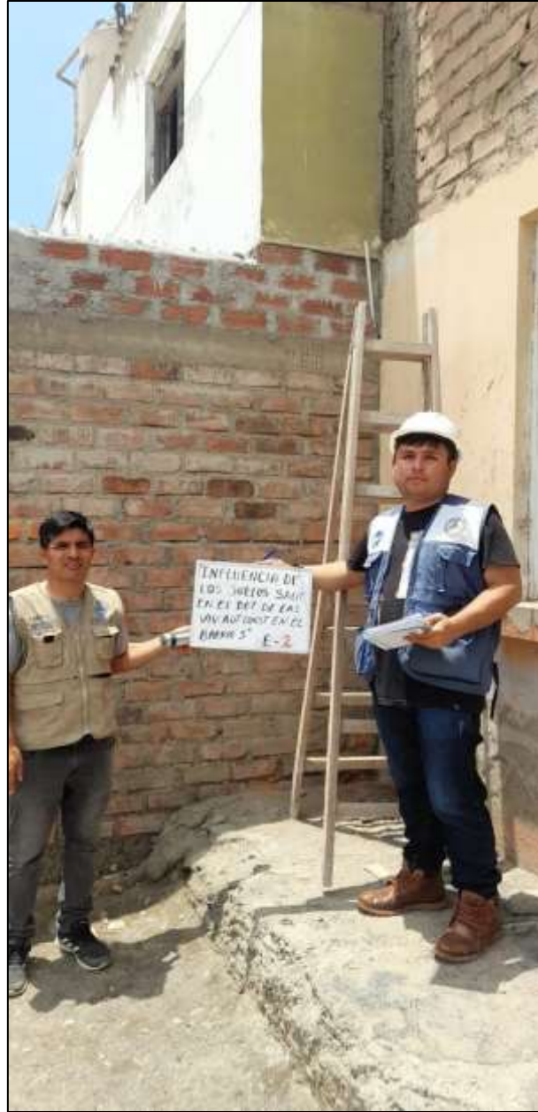
Ensayo de esclerometría.
