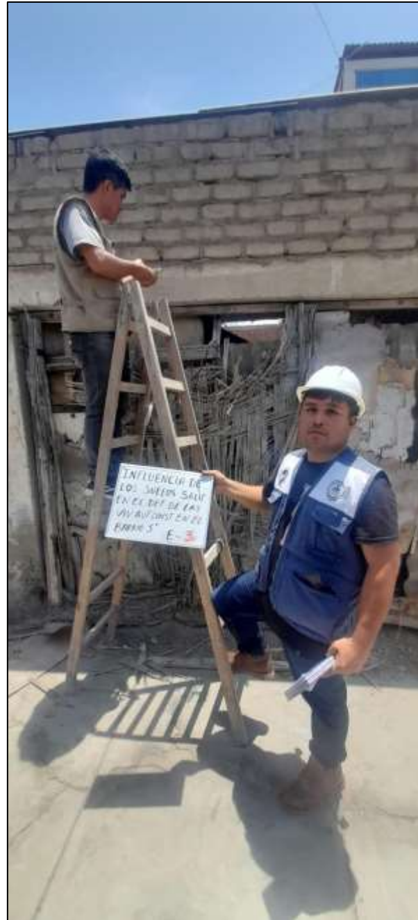
Ensayo de esclerometría en vigas.
