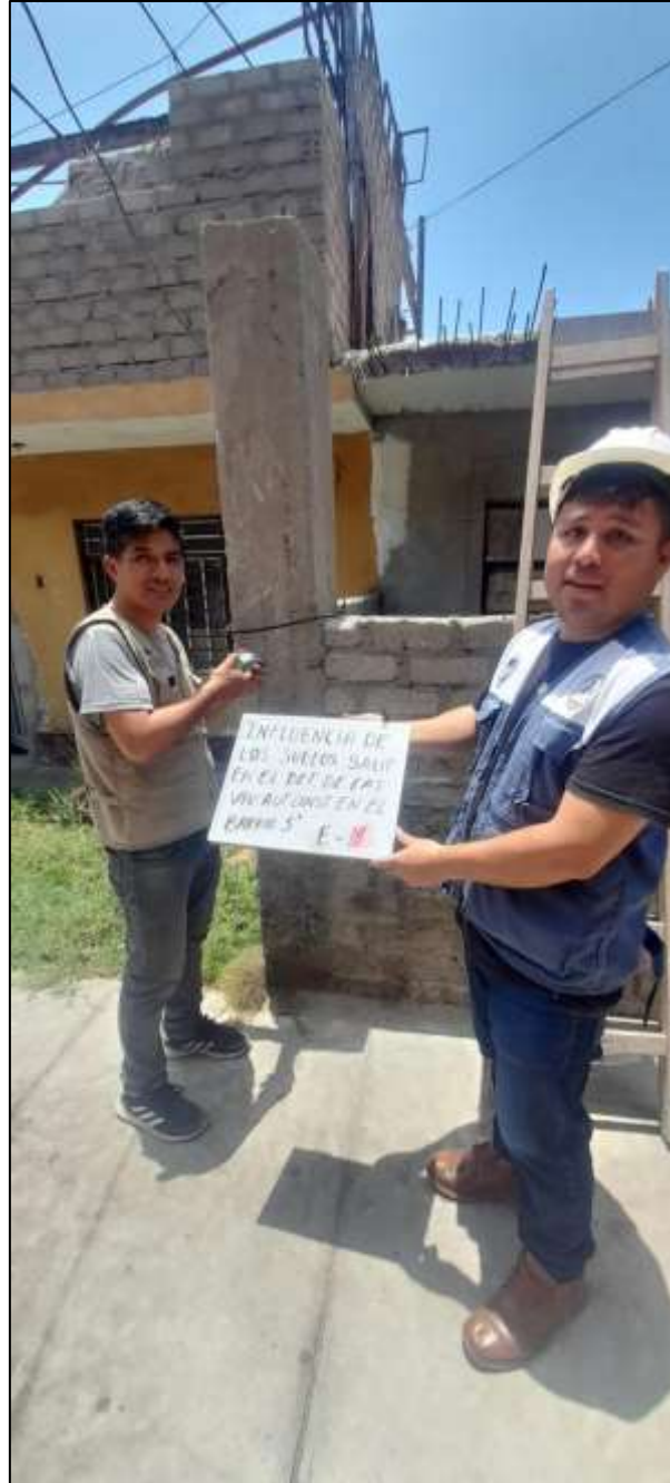
Ensayo de esclerometría junto con el ingeniero a cargo de laboratorio.
