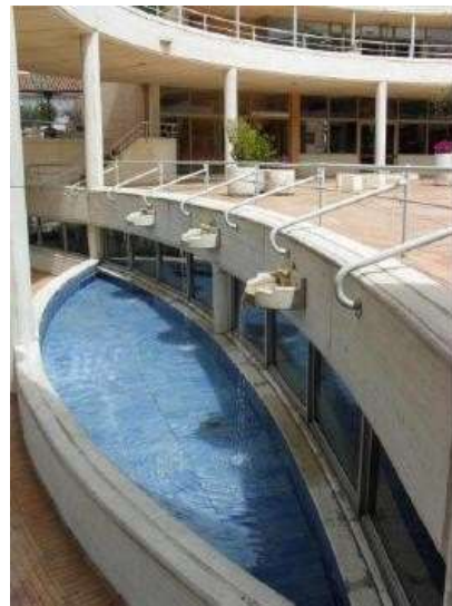
Figura 75: Estanque de bienvenida en el acceso principal al edificio.
