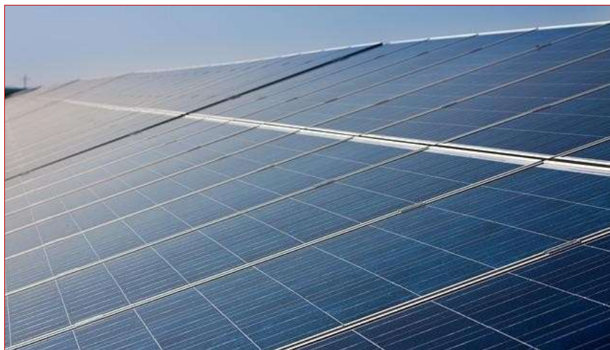
Figura 143: Panel solar fotovoltaico policristalino
