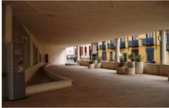
Figura 63: Recorrido de acceso por calle once
