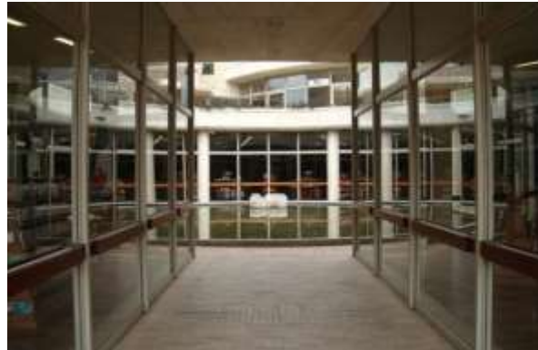
Figura 64: Umbral hacia patio de estanque circular
