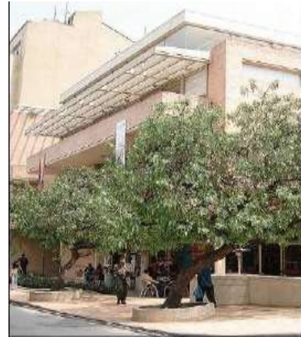
Figura 76: Árboles y jardín como transición entre la ciudad y el edificio, sobre la carrera sexta.
