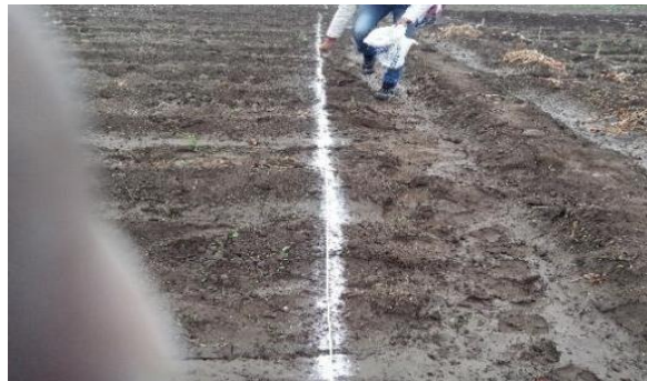
Figura 06: Demarcación con cal
