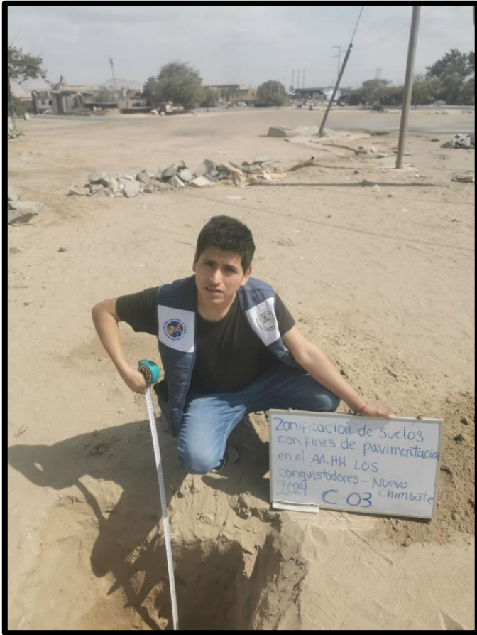
FOTOGRAFIA EXCAVACION DE CALICATA C-03
