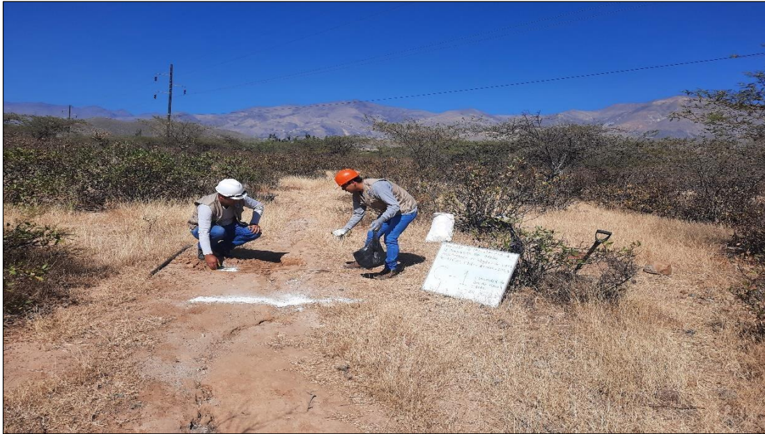
Fotografía N° 01.- Ubicación y trazo de la calicata de la zona de Llacta.
