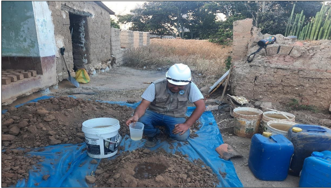
Fotografía N° 11.- Adición del agua a todos los tratamientos del suelo.
