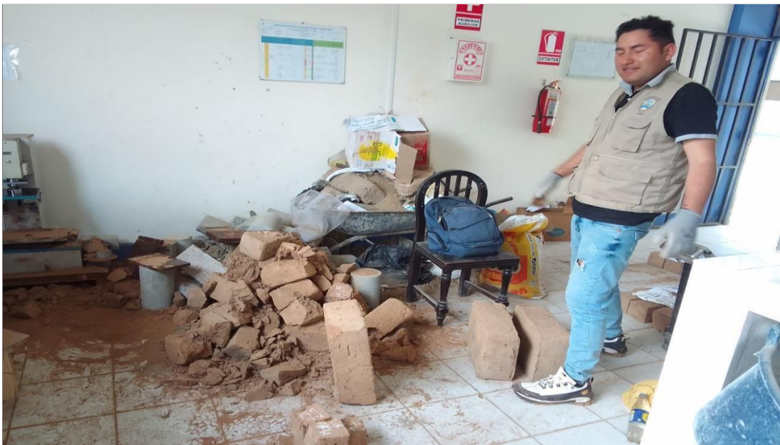
Fotografía N° 24.- El desmonte luego de haber realizado los ensayos de resistencia a la compresión de los adobes.
