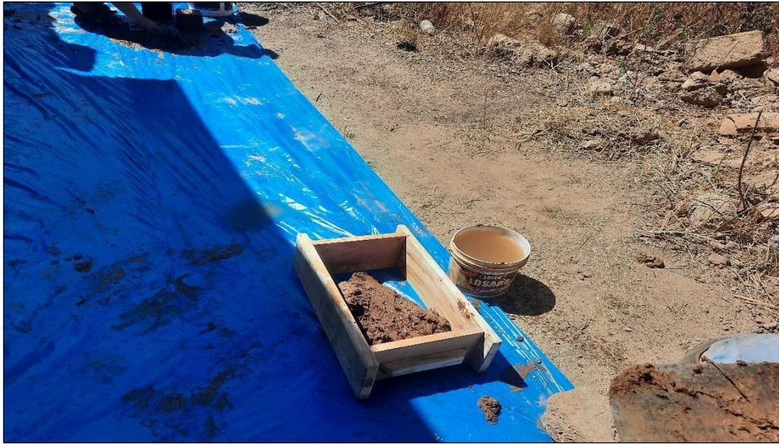
Fotografía N° 17.- Elaboración de adobes de de 0. 40 m. x 0. 30m. x 0.15m.
