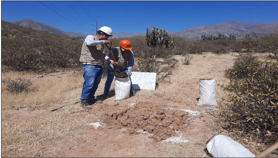
Fotografía N° 07.- Embolsado de la tierra en sacos de 25 kg. Para su respectivo traslado a la zona adecuada para su respectiva elaboración de adobes.
