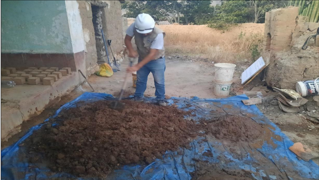
Fotografía N° 12.- Mezclado del barro, para su posterior reposo de 48 horas.
