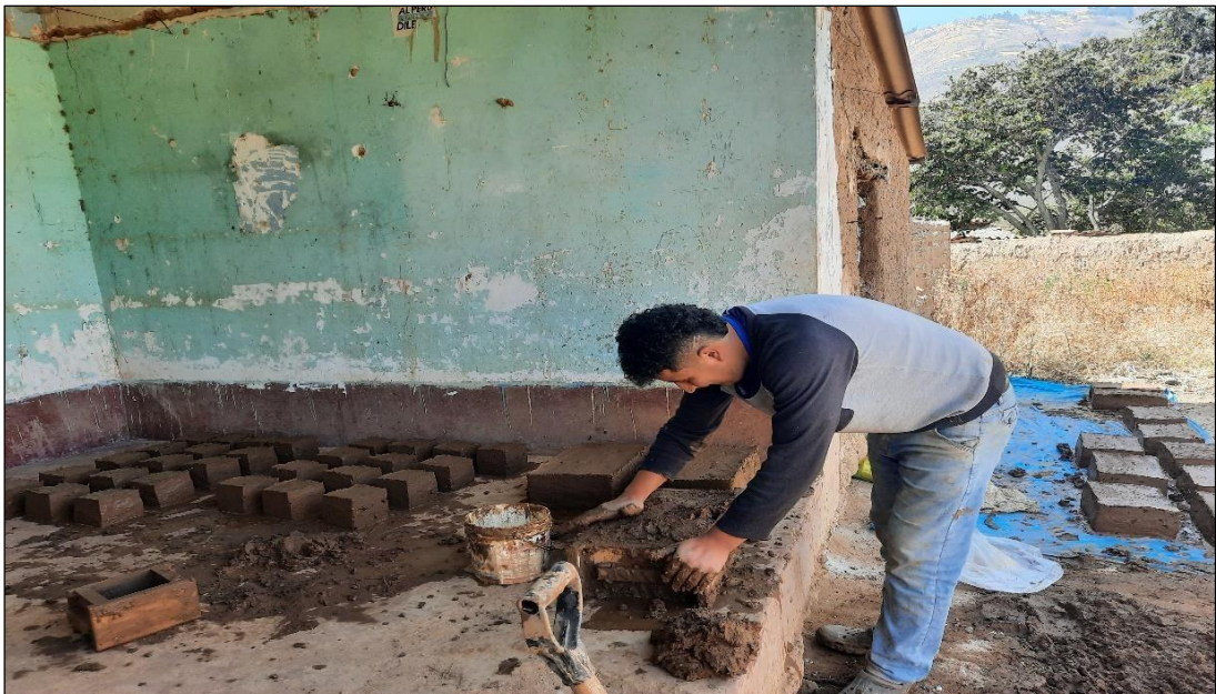
Fotografía N° 18.- Se aprecia la elaboración de adobes en sus dos medidas.
