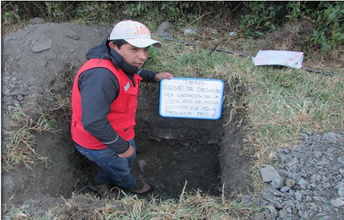
Figura 26: Llegando a la medida de la calicata
