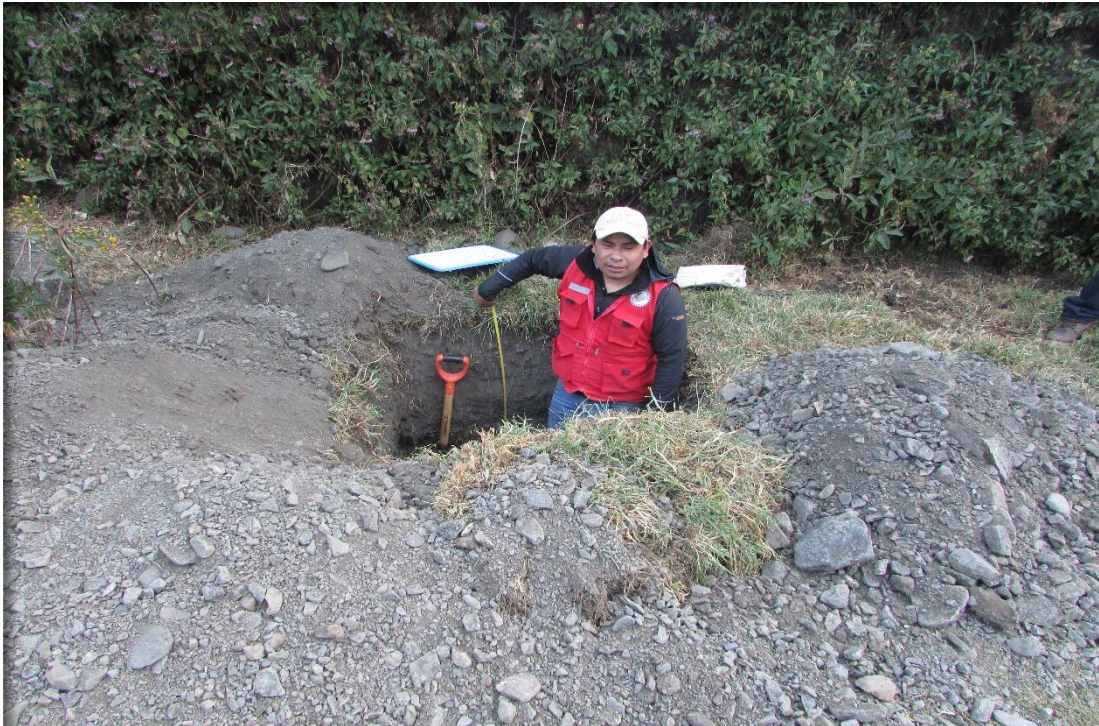
Figura 24: Realizando la calicata para el estudio de suelos
