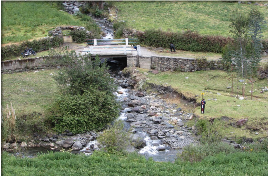
Figura 20: realizando el estudio de suelos y topográfico de quebrada Pomay
