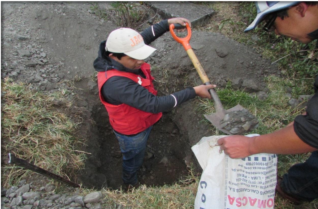
Figura 27: Extrayendo muestra de la calicata para los ensayos respectivos
