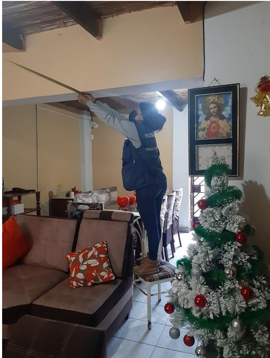
Distanciamiento de vigas peraltadas y cubierta aceptable.
