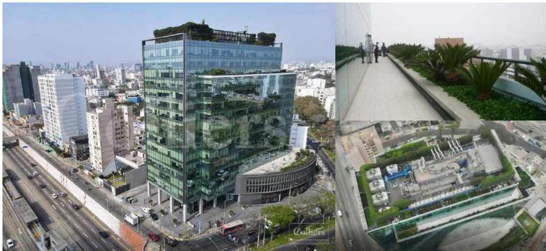
Figura 21. Vista superior del Centro Empresarial Leuro y terrazas. Fuente: Municipalidad de Miraflores
