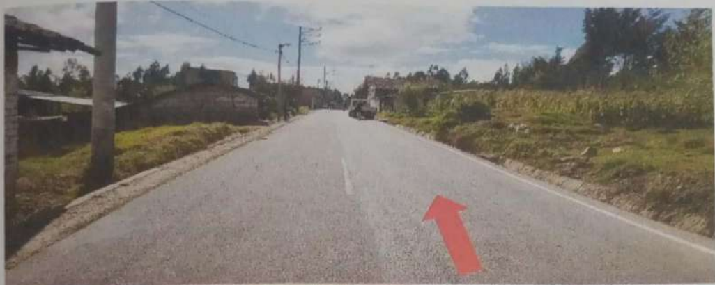
VISTA PANORAMICA DEL LUGAR DEL ACCIDENTE, TOMADA DE OESTE A ESTE (CAJAMARCA - JESÚS), DONDE SE APRECIA LA CONFIGURACION DE LA VIA Y LA FLECHA INDICA EL SENTIDO DE CIRCULACION DE LA UT1.
