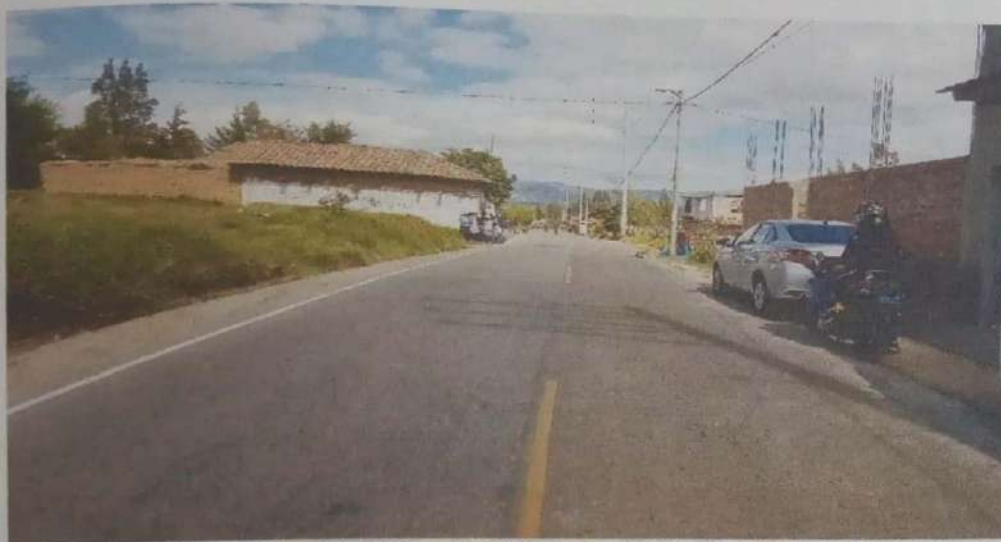
VISTA PANORAMICA DEL LUGAR DEL ACCIDENTE, TOMADA DE ESTE A OESTE (JESÚS - CAJAMARCA), DONDE SE APRECIA LA CONFIGURACION DE LA VIA Y LA FLECHA INDICA EL SENTIDO DE CIRCULACION DE LA UT-2
