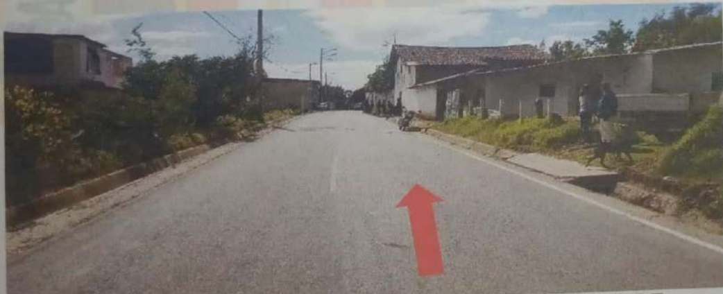
VISTA FOTOGRÁFICA CON ACERCAMIENTO, TOMADA DE OESTE A ESTE (CAJAMARCA - JESÚS), DONDE SE APRECIA EL SENTIDO DE CIRCULACION DE LA UT-1.
