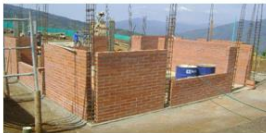
Figura 7: Vivienda Construida con Albañilería Armada
