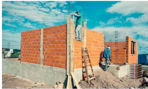
Figura 8: Vivienda Construida con Albañileria Confinada
