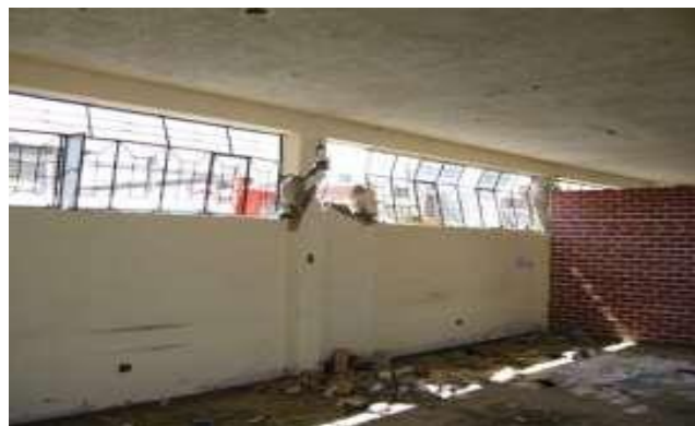
Figura N°03: Columna Corta - Fallas
