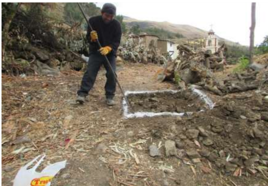
Figura 30: iniciando la excavación.
