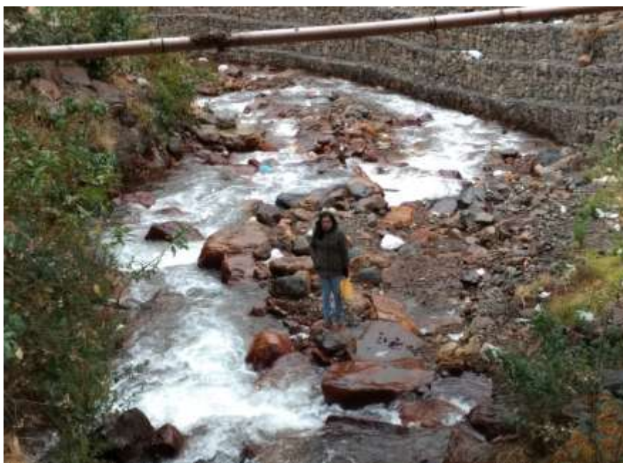
Figura 39: parte baja del puente Tarica I.
