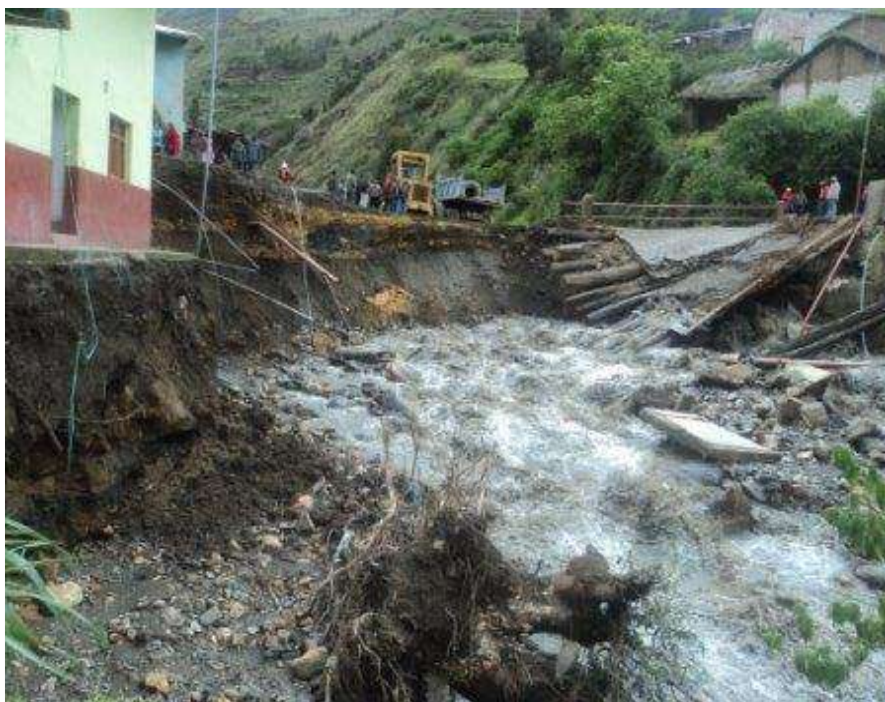
Figura 21: crecida del caudal derrumbes deslizamiento.
