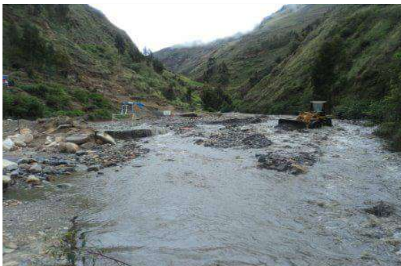
Figura 2: Inundación por las precipitaciones de la localidad de Tarica.
