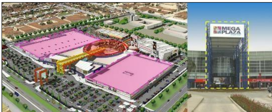
Figura 16: Análisis Formal de la fachada y volumetría del Centro comercial Mega Plaza Norte, Lima Fuente: Elaboración Propia
