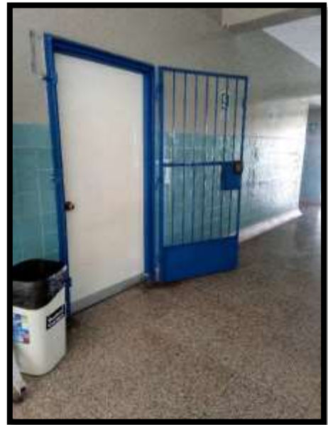
PUERTA DE INGRESO AL CENTRO DE DATOS
