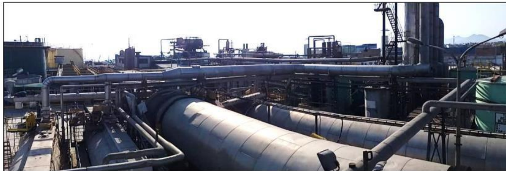
SUMINISTRO Y MONTAJE DE DUCTOS DE VAHOS // CENTINELA - CHANCAY
