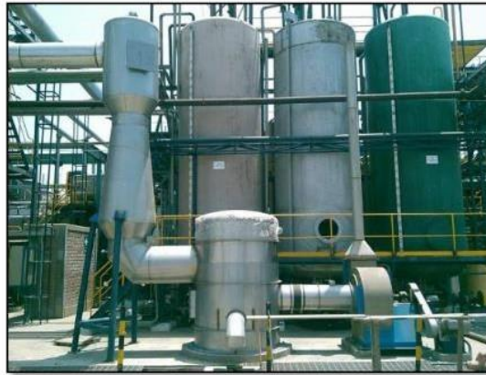
FABRICACION DE LAVADOR DE VAHOS FUGITIVOS
