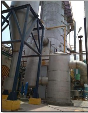
FABRICACION DE LAVADOR DE VAHOS – PESQUERA CENTINELA
