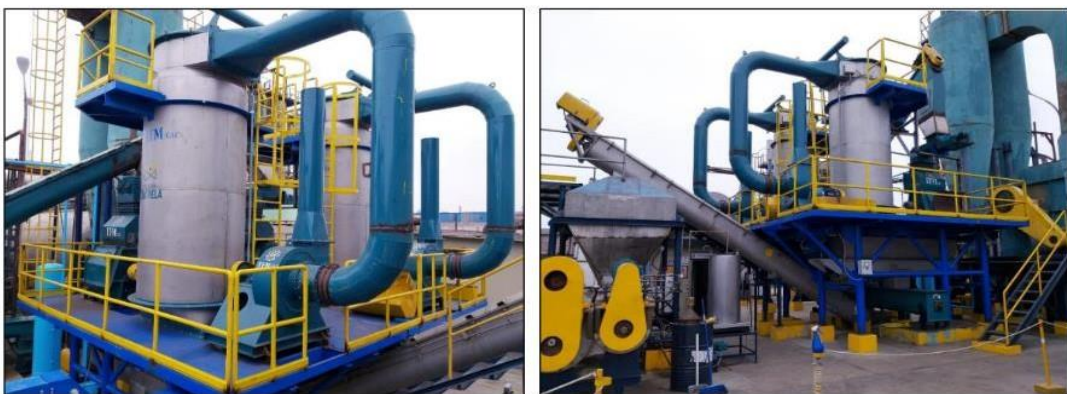
FABRICACION Y MONTAJE DE SISTEMA DE MOLIENDA // CENTINELA - CHANCAY
