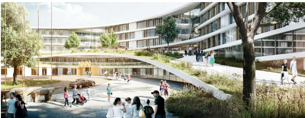
Figura 53: NyT HOSPITAL NORDSJAELLAND. Patio interior Fuente: Plataforma Arquitectura cortesía de Herzog & de Meuron
