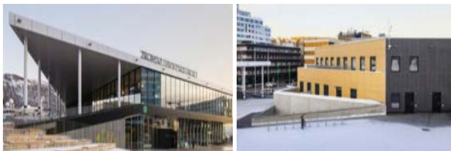
Figura 32: Vistas laterales de la edificación. Fuente: Archdaily.com
