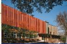
Fachada Este La fachada este y oeste poseen paneles o invidos de malla metálica en un ángulo de 51° en verano, para controlar el ingreso de calor y proteger el ingreso de luz solar durante la tarde.
