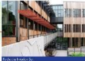
Fachada Interior Sur La fachada interior sur presenta elementos de protección al sol en un ángulo de 51° en verano, para controlar el ingreso de calor y proteger el ingreso de luz solar durante la tarde.
