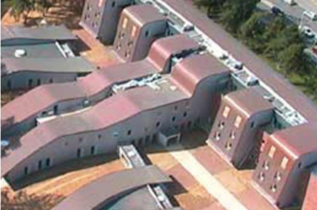
Figura 19. Centro de servicio se psiquiatría del hospital de Arras-Francia. Fuente: Floornature.es
