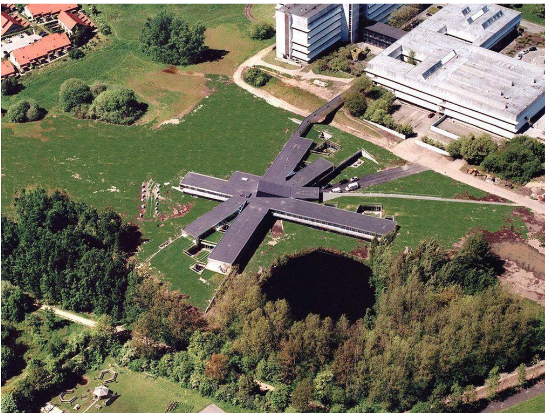
Figura 32. Clínica Psiquiátrica Ellsinore- vista aérea.
