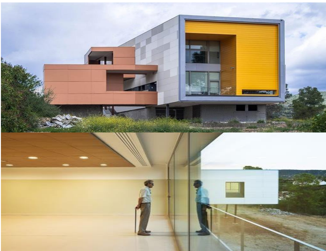
Figura 26. Centro para discapitados psíquicos de alcolea en Córdoba. Fuente: Pag. Arquitectura contemporánea
