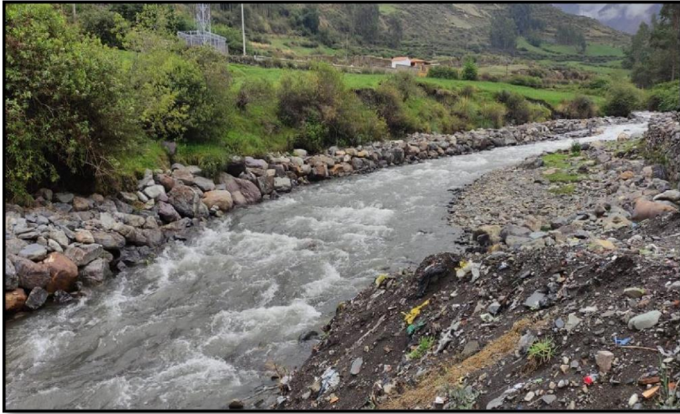
Imagen N° 03: Se observa los desmontes y los residuos sólidos que hay en el río Pativilca y que obstruye el paso del agua. Fuente: Elaboración Propia.
