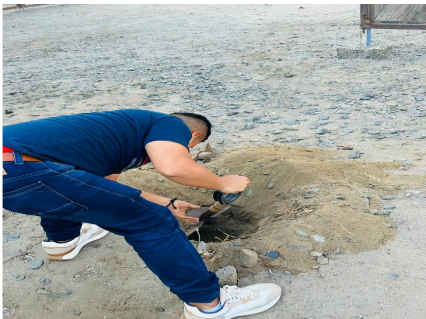
FOTO N°4: EXCAVACIÓN DE LA CALICATA PARA SU POSTERIOR TOMA DE MUESTRA.
