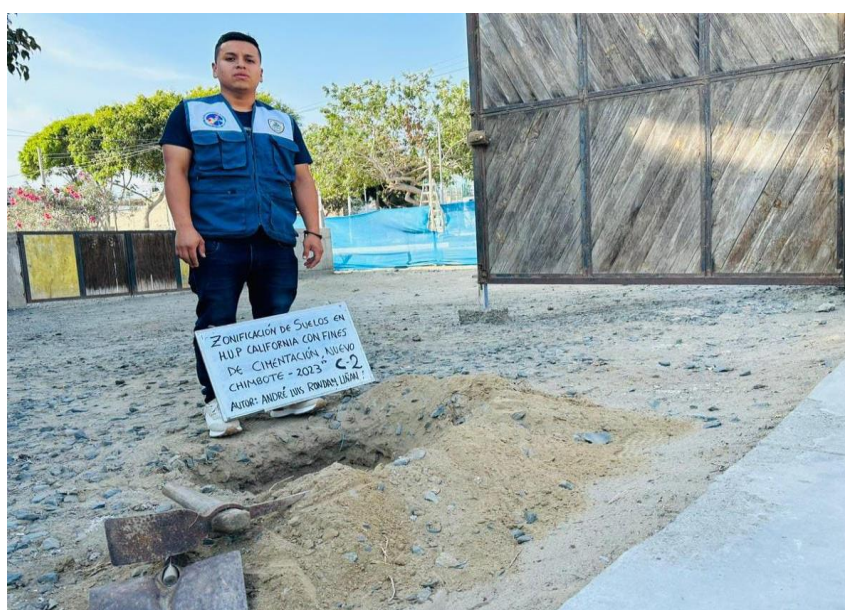
FOTO N°2: EXCAVACIÓN DE LA CALICATA 2 EN LA HABILITACION URBANA PROGRESISTA CALIFORNIA.
