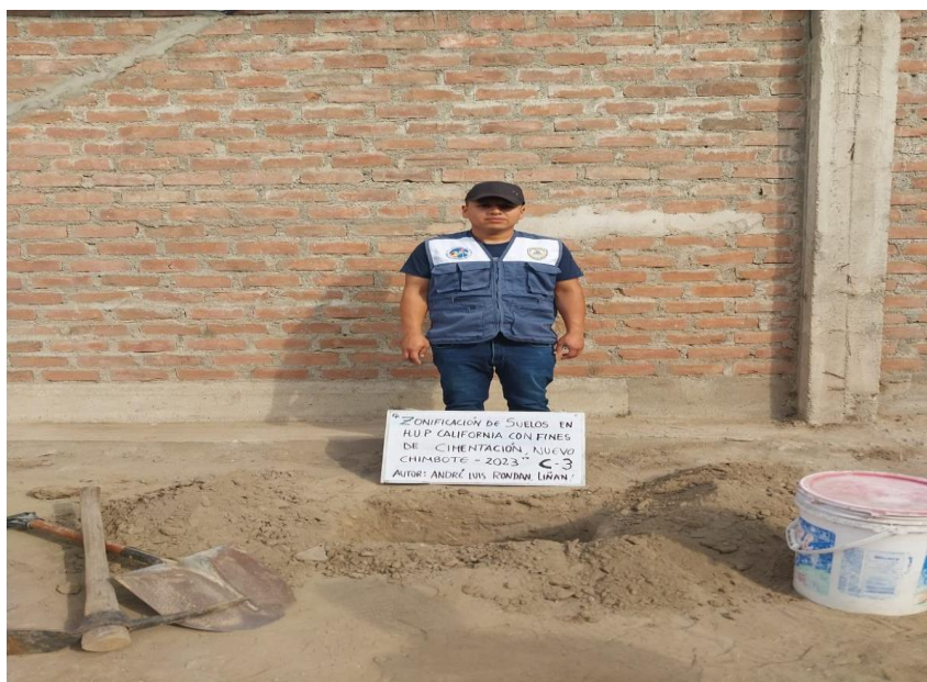
FOTO N°3: EXCAVACIÓN DE LA CALICATA 3 EN LA HABILITACION URBANA PROGRESISTA CALIFORNIA.
