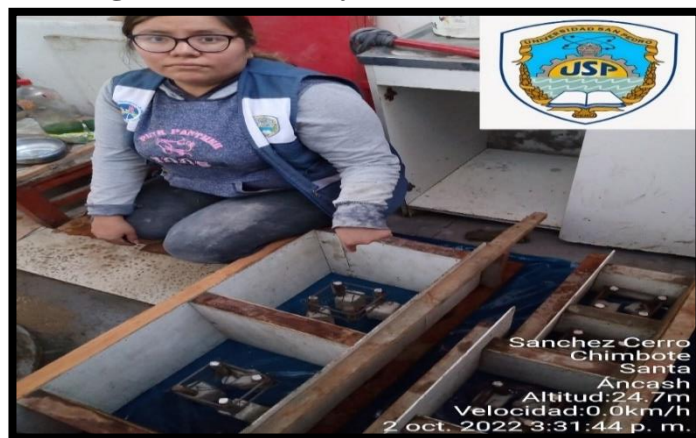
Figura # 27: Encofrado con armaduras para el vaciado
