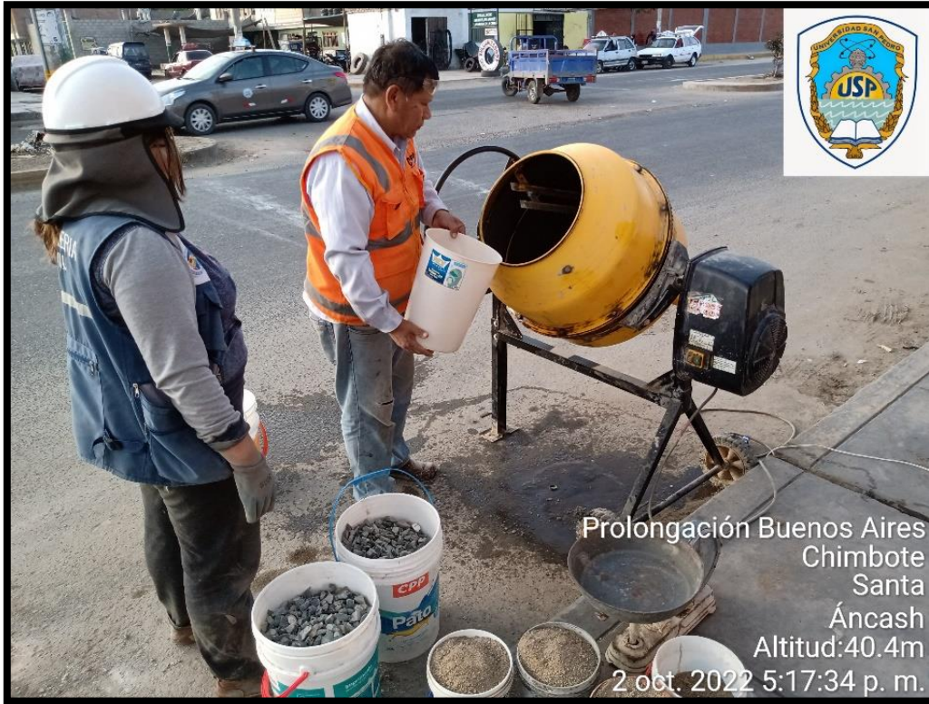
Materiales ya pesados para mezclarse en el trompo.
