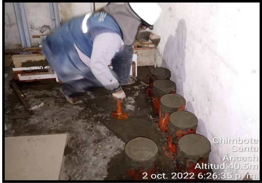
Figura # 32: Vaciado de mezcla a los moldes cilíndricos de concreto.
