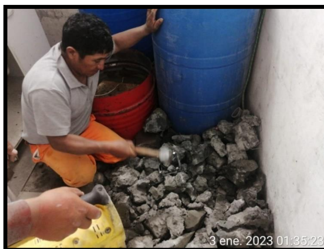
Figura # 39: Rotura de últimos pedazos de concreto atorados en las armaduras.
