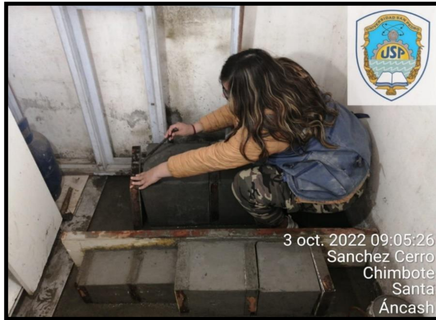
Figura # 34: Desencofrado de cubos de concreto armado
