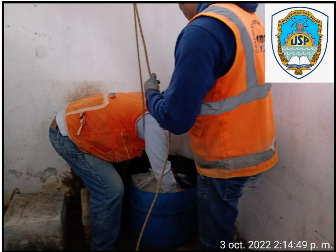
Cubo de 10 cm de recubrimiento dentro de cilindro
