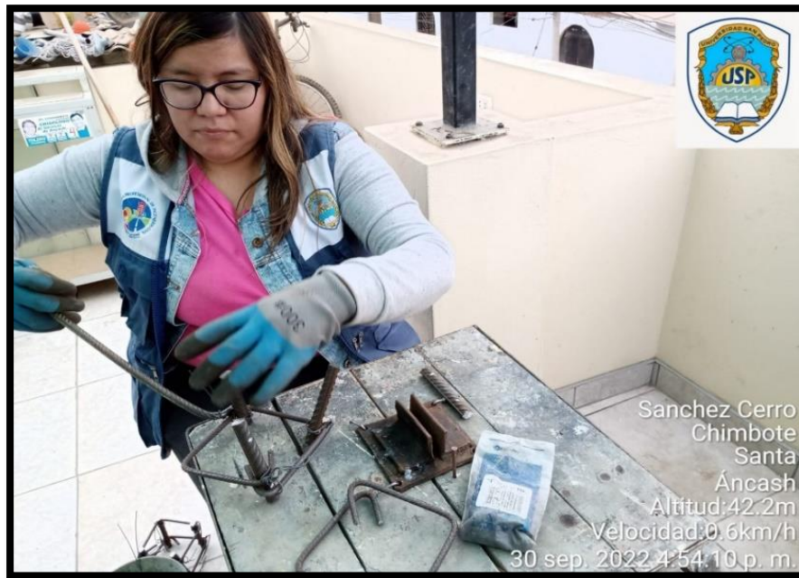
Figura # 18: Amarre de varillas de 5/8” con sus estribos con el uso de alambre N°8
