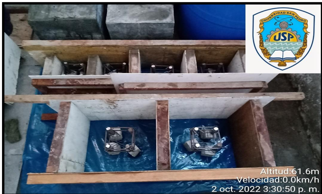
Encofrado con armaduras para el vaciado
