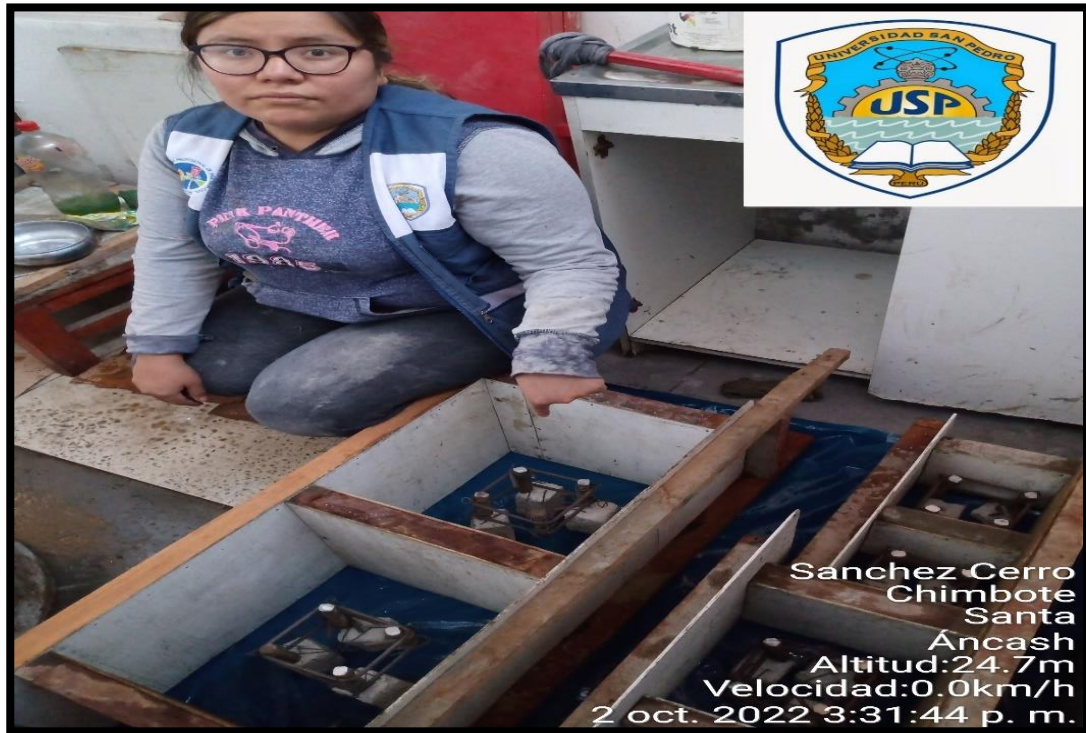
Encofrado con armaduras para el vaciado
