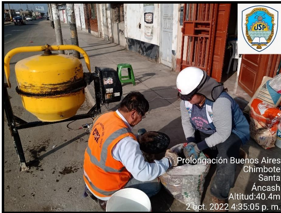
Pesado de agregado grueso (288.86 kg)
