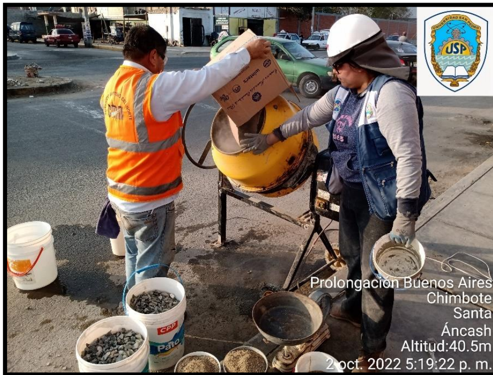
Abastecimiento de cemento al trompo.
