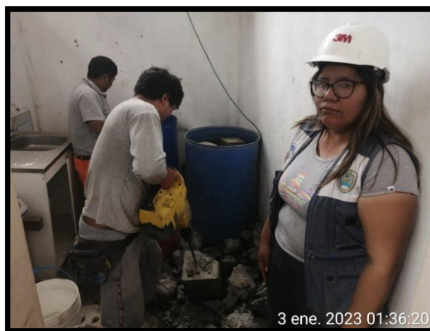
Figura # 38: Rotura de cubos usando uso de rotomartillo
