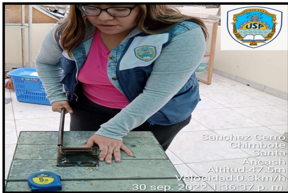
Figura # 17: Doblado de acero de refuerzo (1/4" para estribo)
