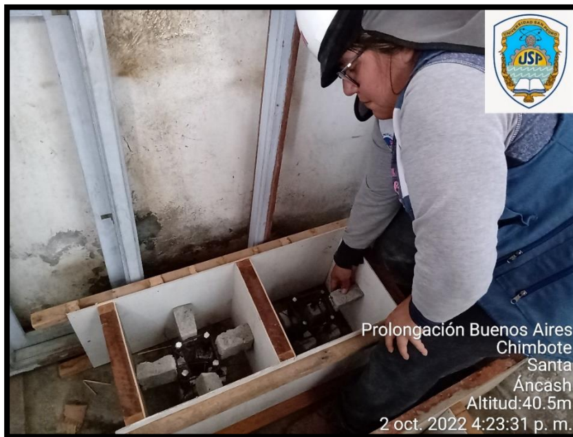
Figura # 28: Colocado de dados para el recubrimiento (10 cm)
