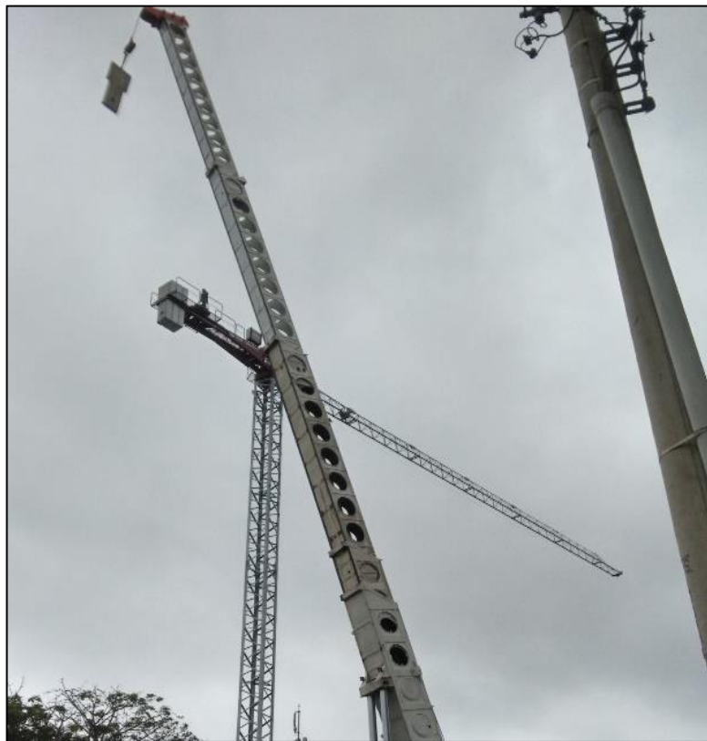
Figura 18: Instalación de contrapesos de grúa torre
