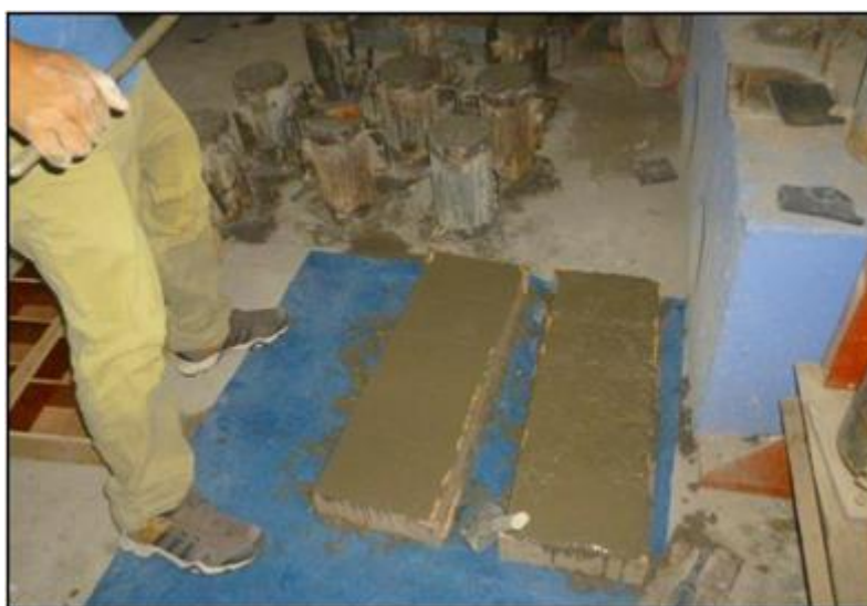
FOTO 15: LLENADO DE CONCRETO A LOS MOLDES
