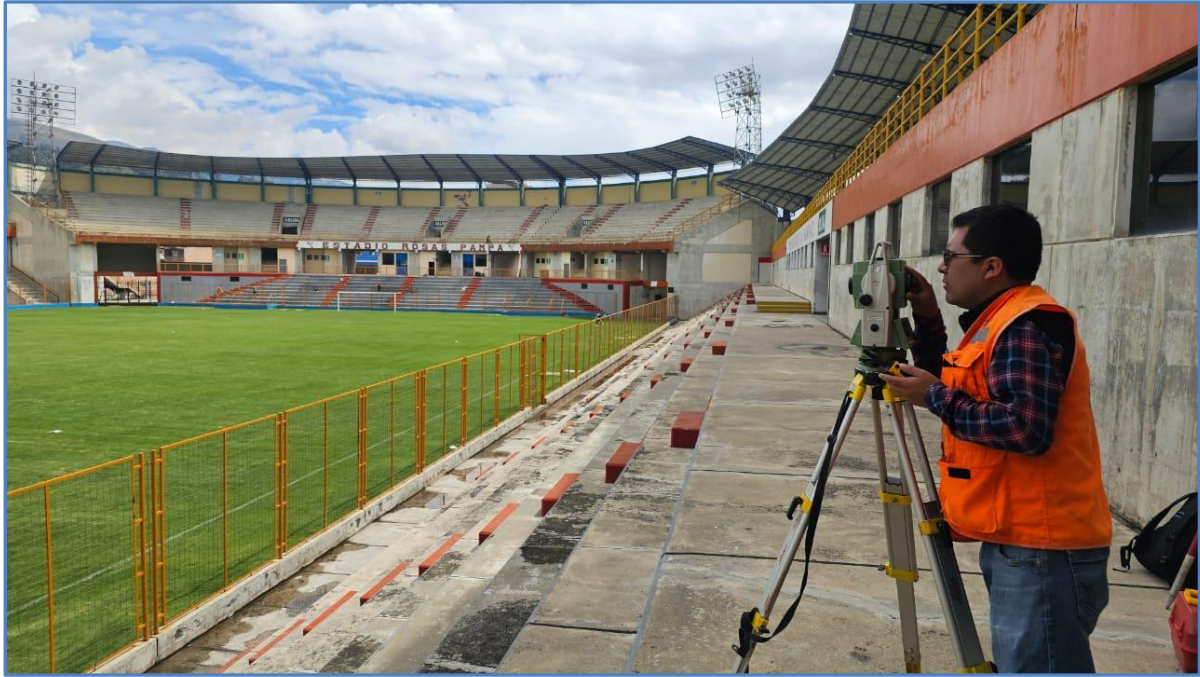
Figura 37 Levantamiento topográfico con Estación Total South N4
