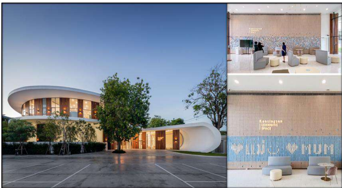
Figura 24. Lenguaje arquitectónico, Materiales y acabados del espacio de aprendizaje de Kensington. fuente: elaboración propia
