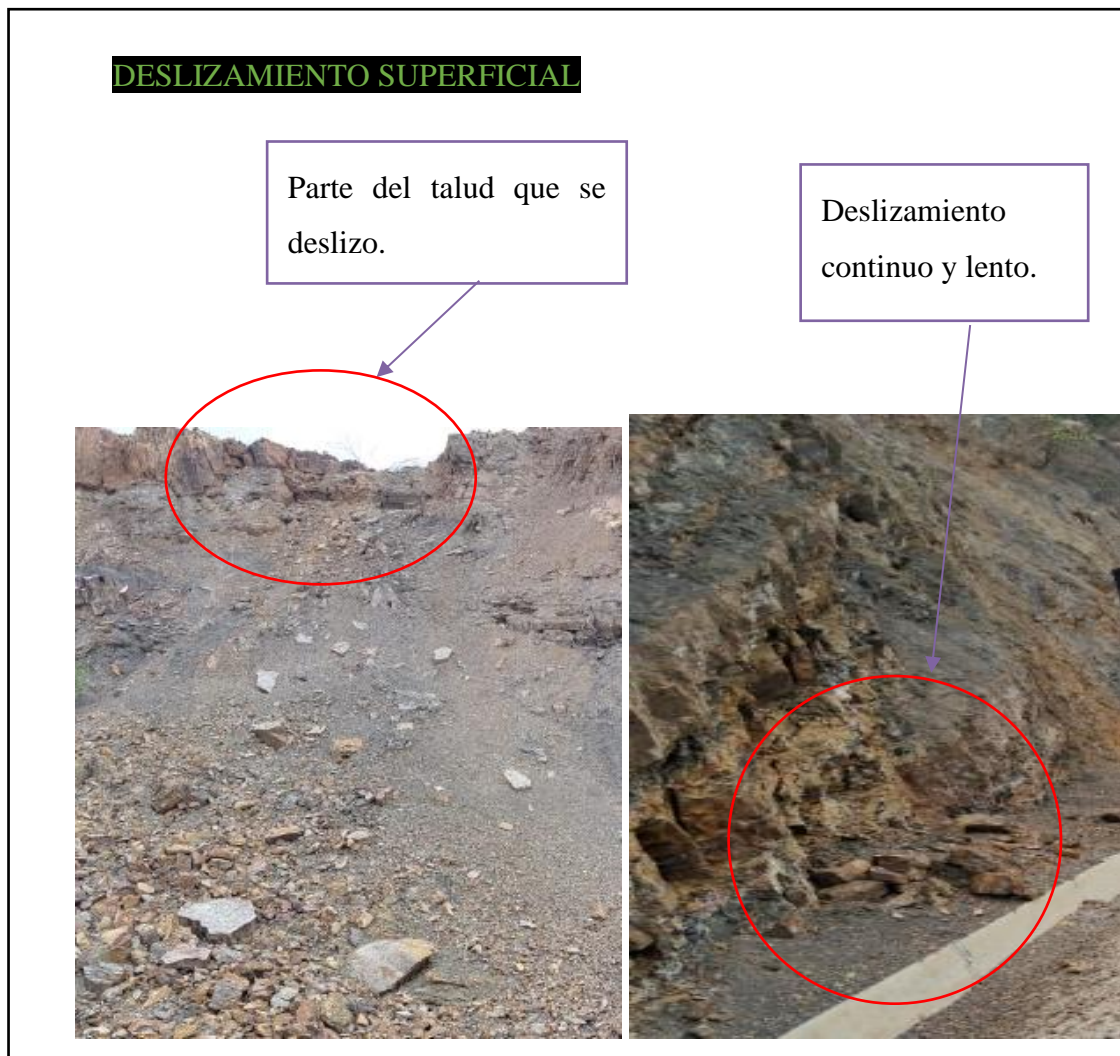
Figura 10. Deslizamiento lento y continuo.
