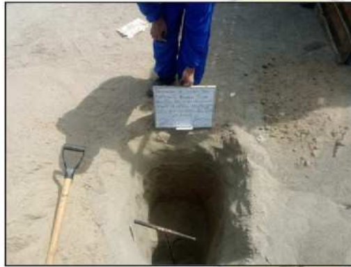
FOTO 03: SE OBSERVA LA EXCAVACIÓN CALICATA C-02.
