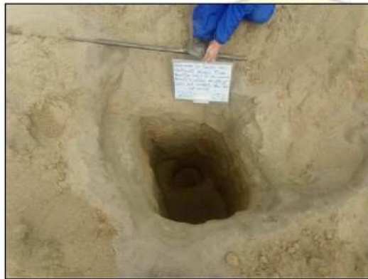
FOTO 01: SE OBSERVA LA EXCAVACIÓN CALICATA C-01.
