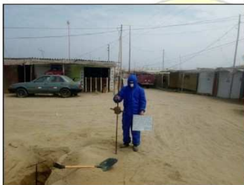
FOTO 09: SE OBSERVA LA AUSCULTACION DPL-03 .
