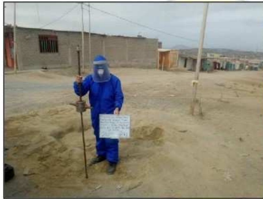
FOTO 07: SE OBSERVA LA AUSCULTACION DPL-01.
