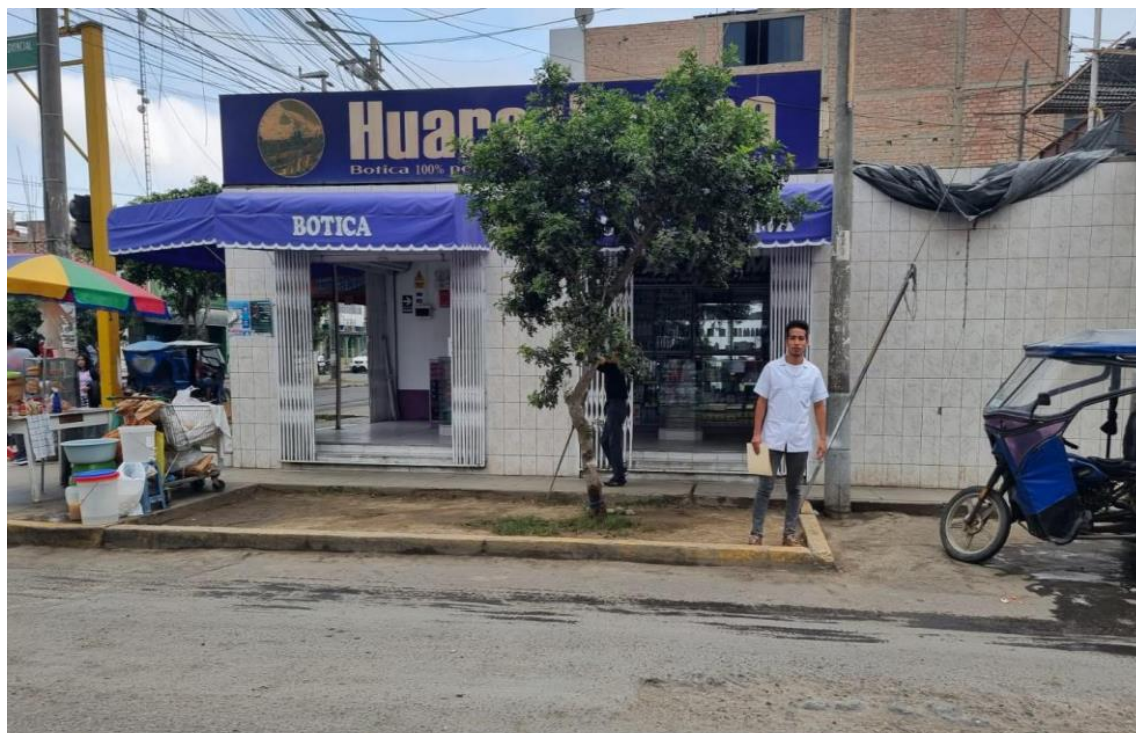
Fotografía 1. Vista por fuera del local.
