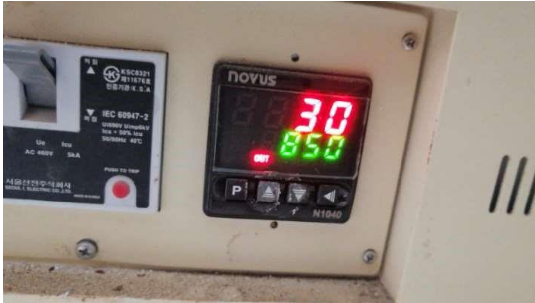
Preparación de diseño de concreto
