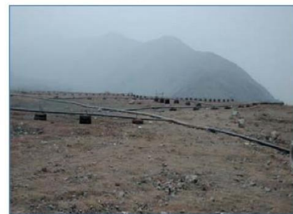
Pozos de extracción de gas
