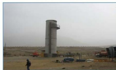
Quemador de Biogás
