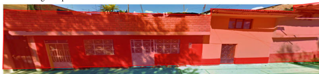
Figura 9. Perfil urbano – Lateral izquierdo. Fuente: Google maps
