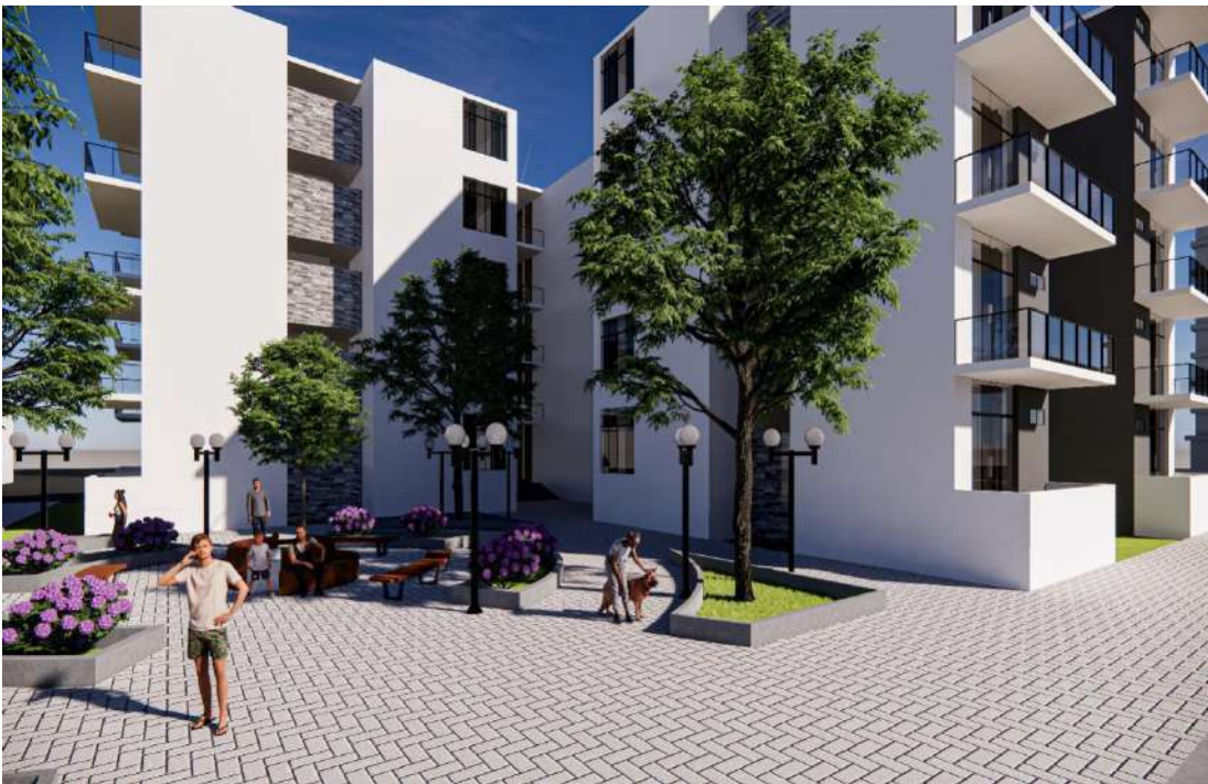
Figura 40 , Zonas complementaria de recreación pasiva del complejo habitacional Fuente: fotos propias
