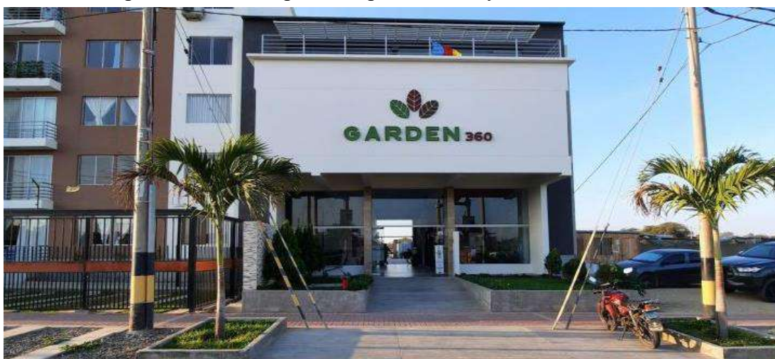
Figura 16 , foto del ingreso principal peatonal a garden 360 Fuente: Google adondevivir
