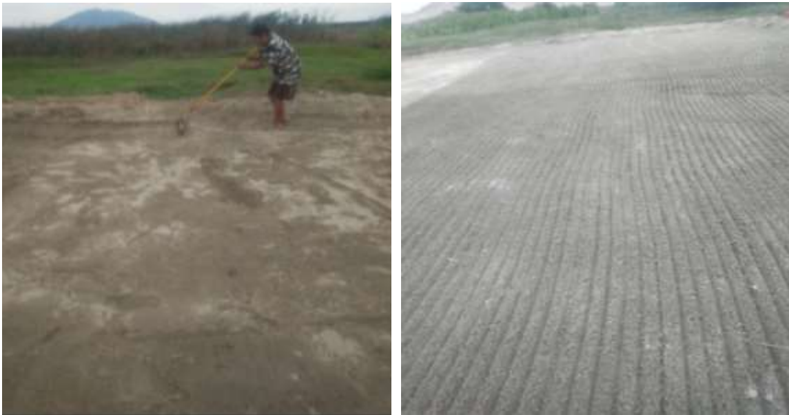
Figura 1. Preparación del terreno
