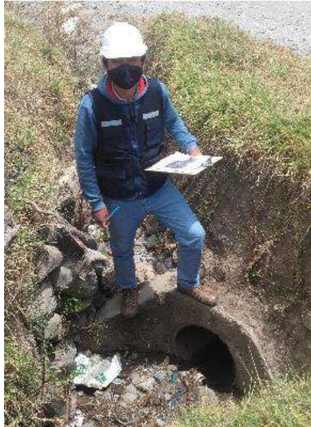
Fotografía N°17: Alcantarilla 12 en la ruta Taricá – Pariahuanca
