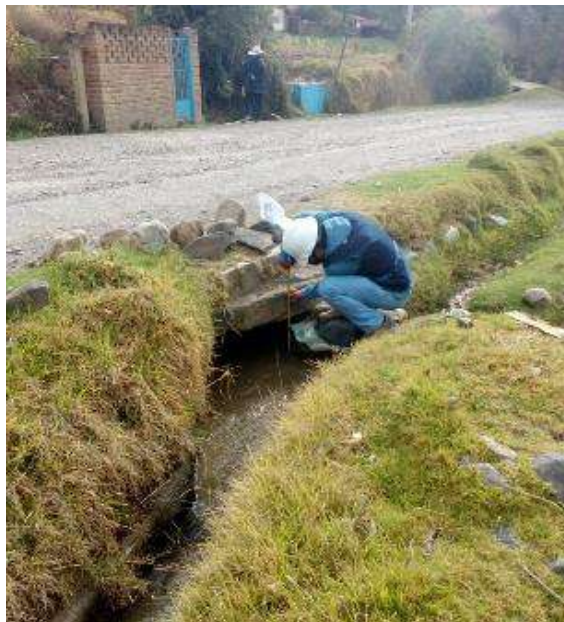
Fotografía N°34: Alcantarilla 24 en la ruta Pariahuanca – San Miguel de Aco
