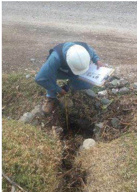
Fotografía N°22: Alcantarilla 14 en la ruta Pariahuanca – San Miguel de Aco
