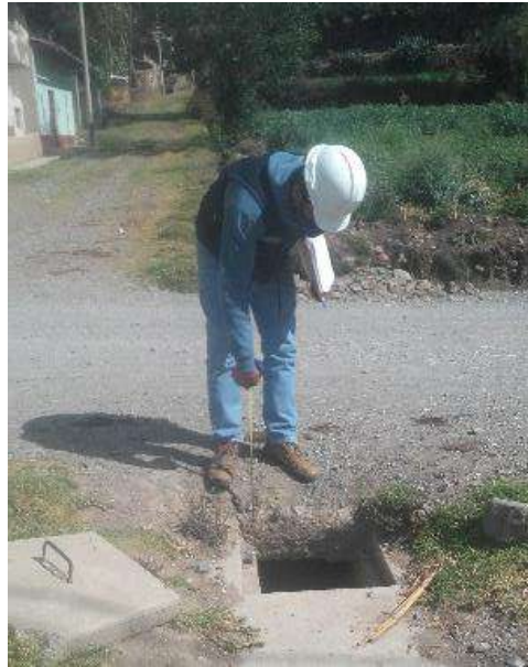
Fotografía N°25: Alcantarilla 17 en la ruta Pariahuanca – San Miguel de Aco
