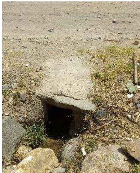
Fotografía N°6: Alcantarilla 5 en la ruta Taricá – Pariahuanca
