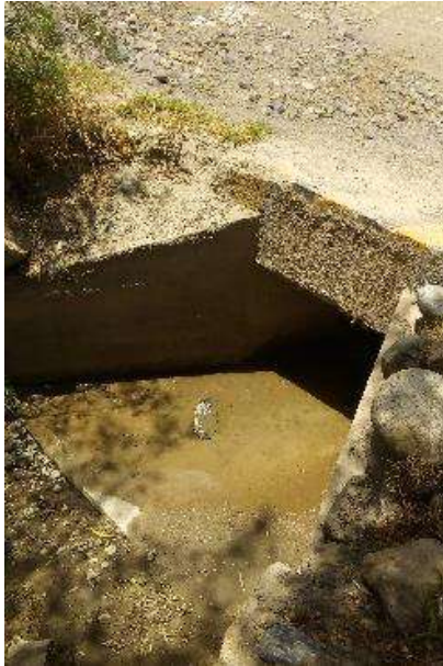
Fotografía N°7: Alcantarilla 6 en la ruta Taricá – Pariahuanca
