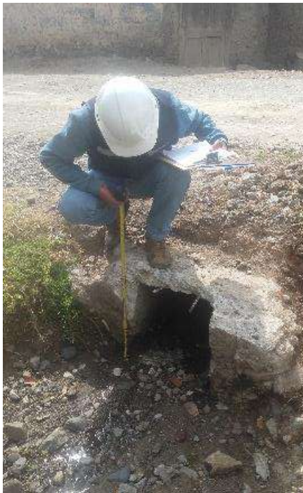
Fotografía N°28: Alcantarilla 20 en la ruta Pariahuanca – San Miguel de Aco
