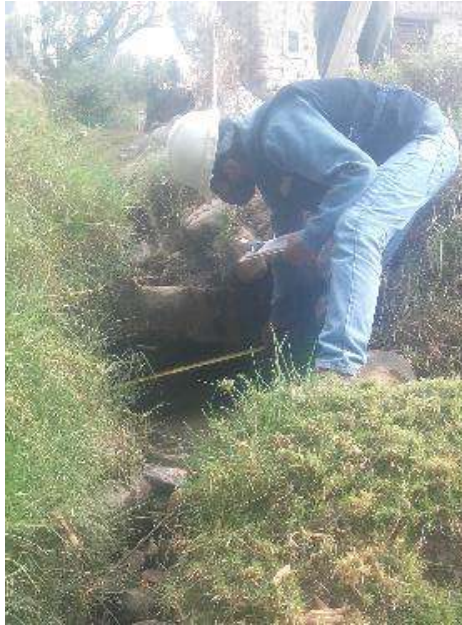
Fotografía N°35: Alcantarilla 25 en la ruta Pariahuanca – San Miguel de Aco
