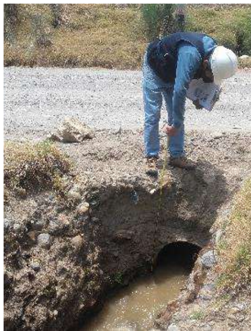
Fotografía N°16: Alcantarilla 11 en la ruta Taricá – Pariahuanca
