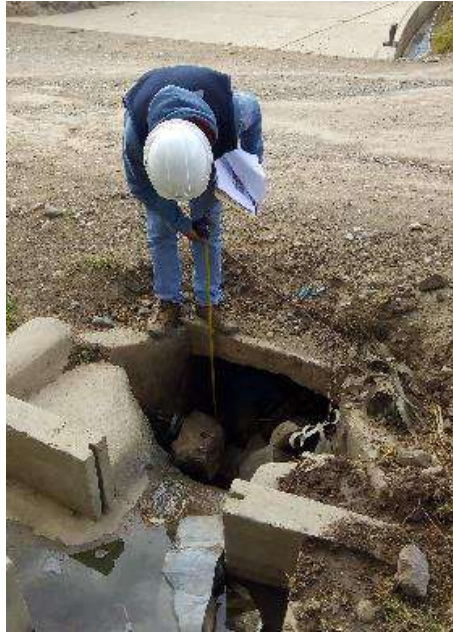
Fotografía N°21: Alcantarilla 13 en la ruta Pariahuanca – San Miguel de Aco
