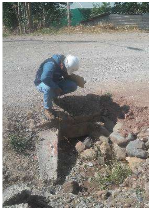
Fotografía N°26: Alcantarilla 18 en la ruta Pariahuanca – San Miguel de Aco
