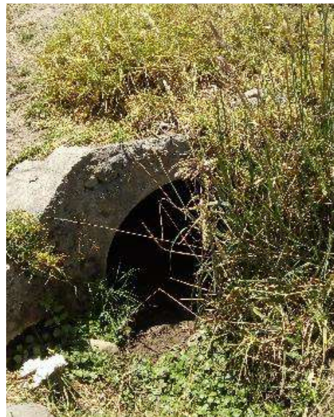
Fotografía N°4: Alcantarilla 3 en la ruta Taricá – Pariahuanca
