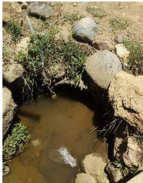
Fotografía N°2: Alcantarilla 1 en la ruta Taricá – Pariahuanca
