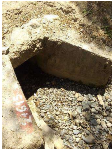
Fotografía N°10: Alcantarilla 8 en la ruta Taricá – Pariahuanca
