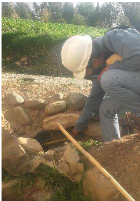
Fotografía N°36: Alcantarilla 26 en la ruta Pariahuanca – San Miguel de Aco
