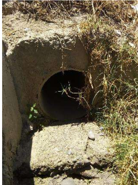
Fotografía N°5: Alcantarilla 4 en la ruta Taricá – Pariahuanca
