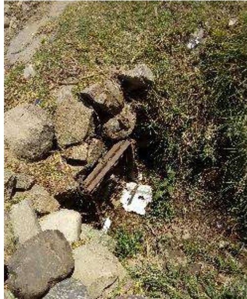
Fotografía N°3: Alcantarilla 2 en la ruta Taricá – Pariahuanca
