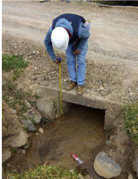
Fotografía N°23: Alcantarilla 15 en la ruta Pariahuanca – San Miguel de Aco
