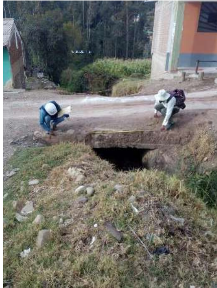
Fotografía N°37: Alcantarilla 27 en la ruta Pariahuanca – San Miguel de Aco
