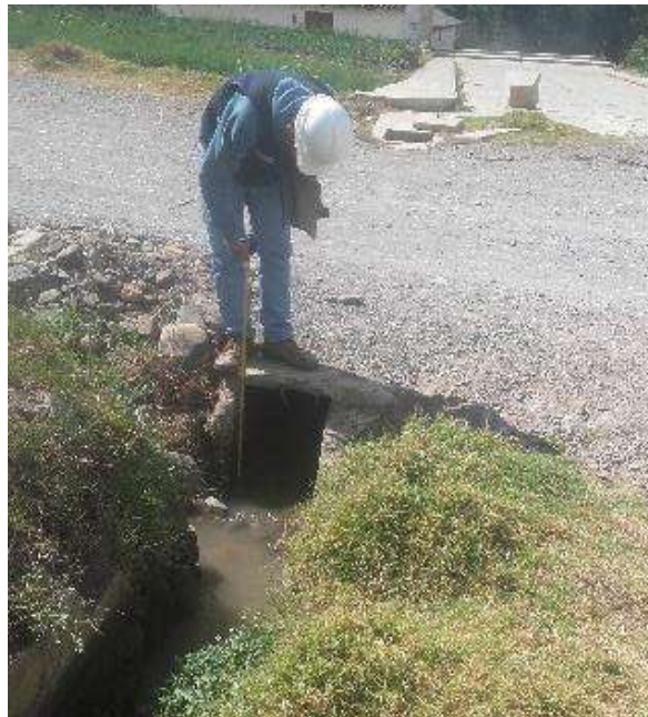
Fotografía N°24: Alcantarilla 16 en la ruta Pariahuanca – San Miguel de Aco
