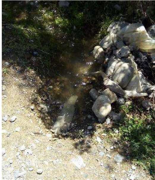
Fotografía N°11: Alcantarilla 9 en la ruta Taricá – Pariahuanca
