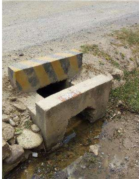
Fotografía N°9: Alcantarilla 7 en la ruta Taricá – Pariahuanca
