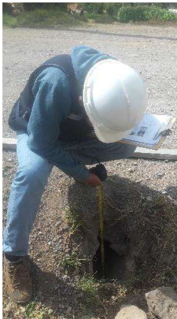
Fotografía N°30: Alcantarilla 22 en la ruta Pariahuanca – San Miguel de Aco
