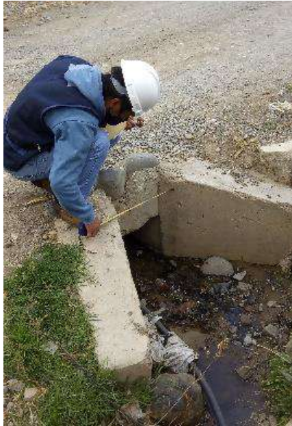
Fotografía N°33: Alcantarilla 23 en la ruta Pariahuanca – San Miguel de Aco
