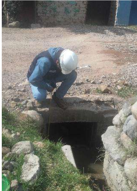
Fotografía N°27: Alcantarilla 19 en la ruta Pariahuanca – San Miguel de Aco
