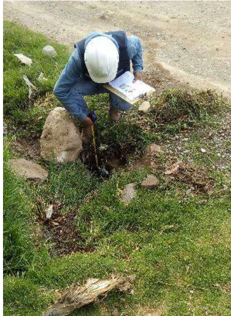
Fotografía N°29: Alcantarilla 21 en la ruta Pariahuanca – San Miguel de Aco
