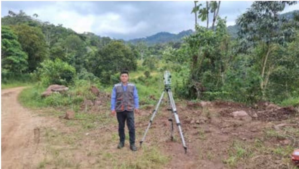
Fotografía N° 9: Trabajo de campo – Levantamiento Topográfico
