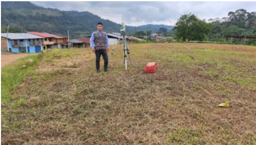
Fotografía N° 6: Trabajo de Campo – Levantamiento Topográfico
