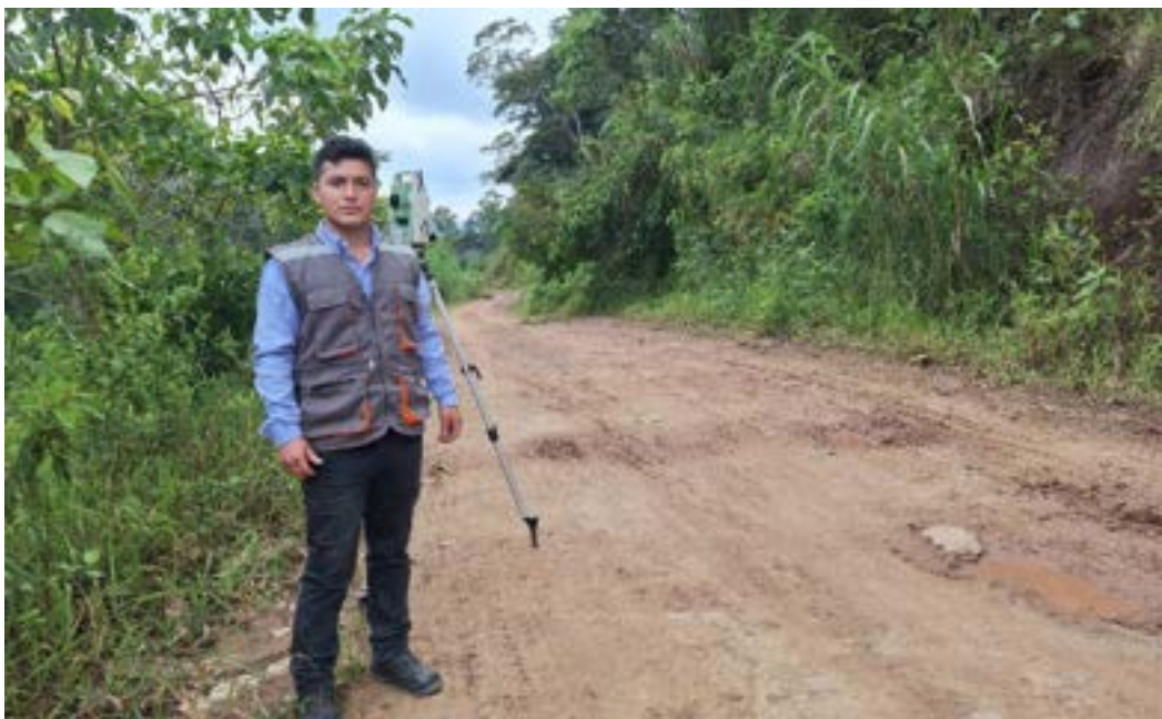
Fotografía N° 10: Trabajo de campo – Levantamiento Topográfico
