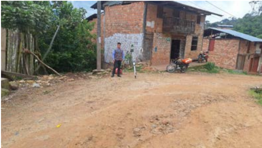
Fotografía N° 5: Trabajo de campo – Levantamiento Topográfico
