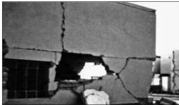
Figura N°10: Albañilería simple (no reforzada)
