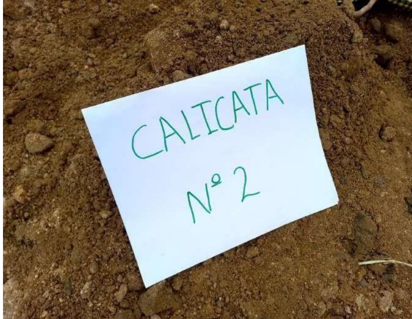
EXCAVACION DE LA CALICATA
