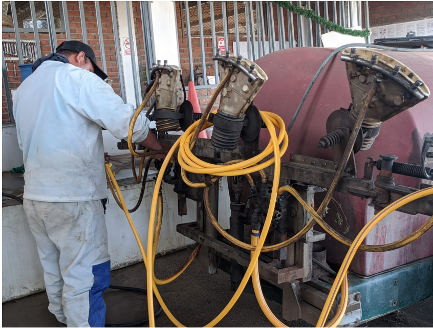
Figura 7. Instalación de las mangueras, adecuadas para la cochinilla.
